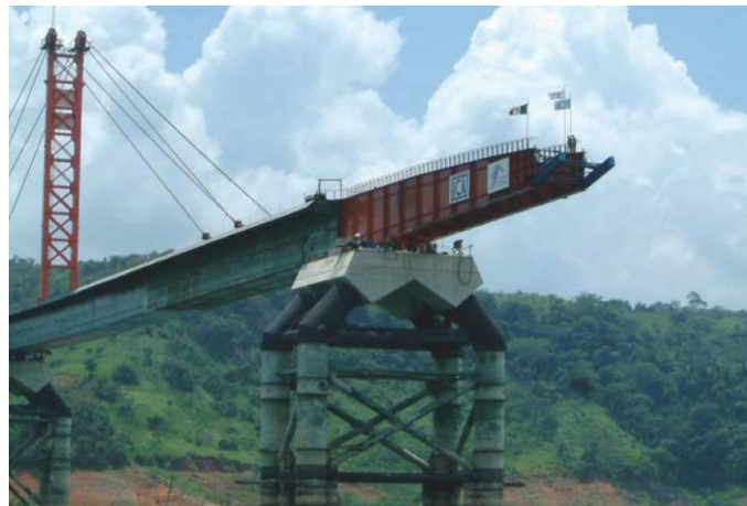
Figura 4.7: Superestructura del puente Chiapas durante su lanzamiento (Monitor, 2008).
