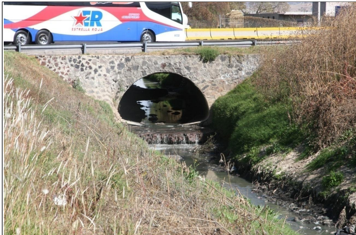
Figura 2.1.1. 2 Alcantarilla del cruce con la Autopista México-Puebla.
