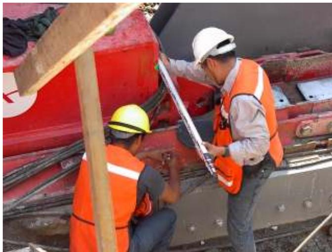
Figura 68. Cada 2 o 3 metros de avance se realizaron mediciones topográficas.
