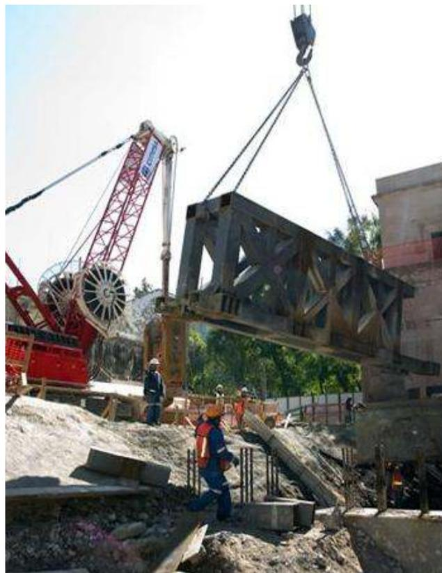
Figura 26a. Izaje de armadura metálica.
