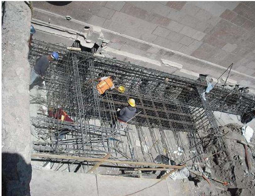
Figura 23a. Detalles de armado de la losa de recimentación en la parte exterior de la casa.
