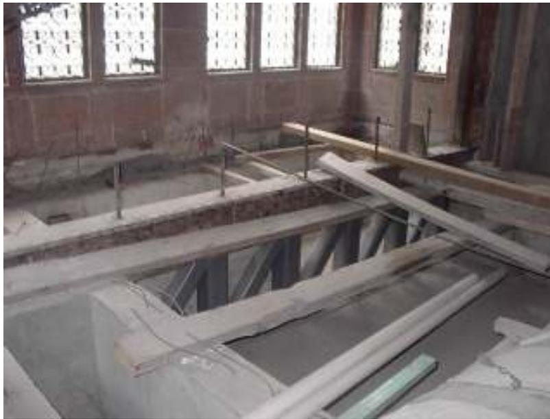
Figura 14a. Empleo de armadura y viga de acero para rigidizar el marco y sujetar tensores.
