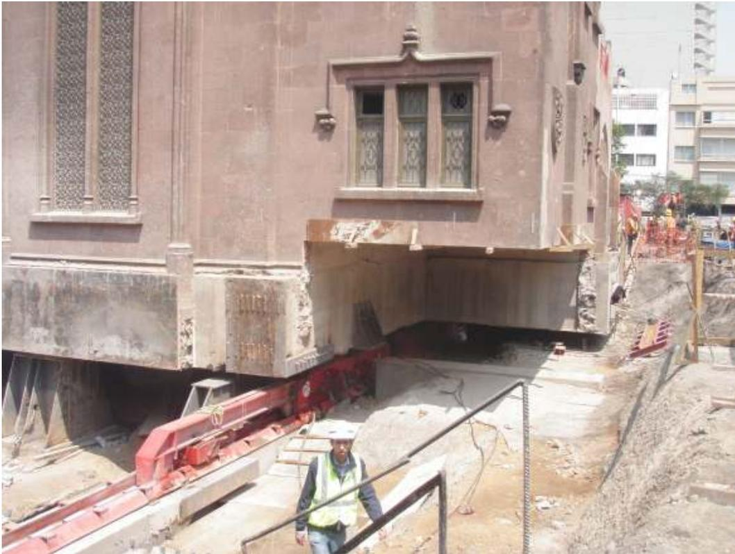
Figura 36. Tren de desplazamiento sobre el eje 3.
