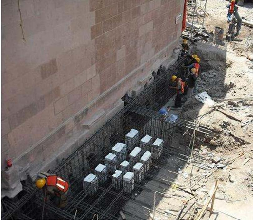
Figura 23b. Detalles de armado y colocación de casetones en losa de recimentación.
