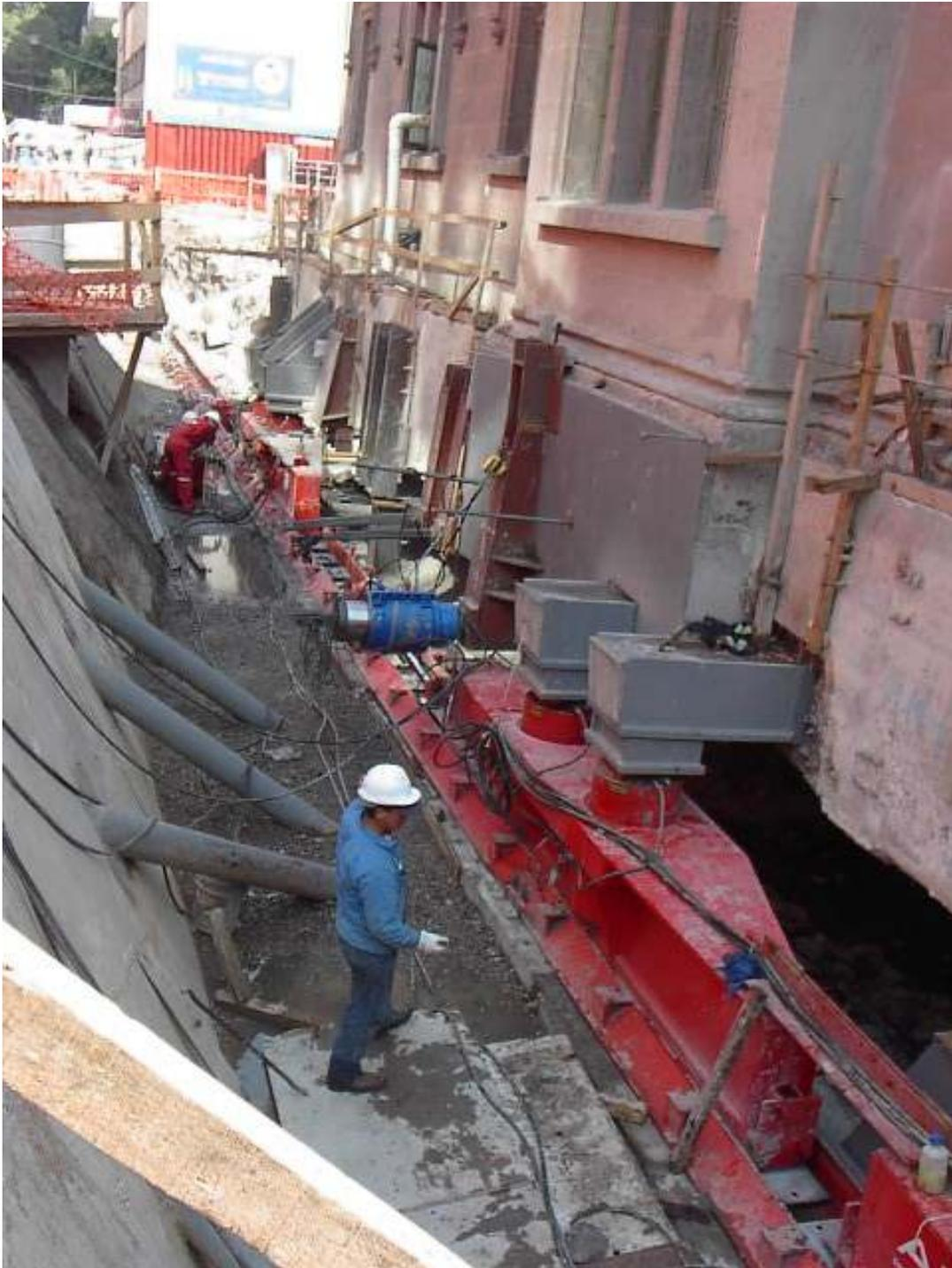
Figura 35. Carril de desplazamiento sobre el eje 4.
