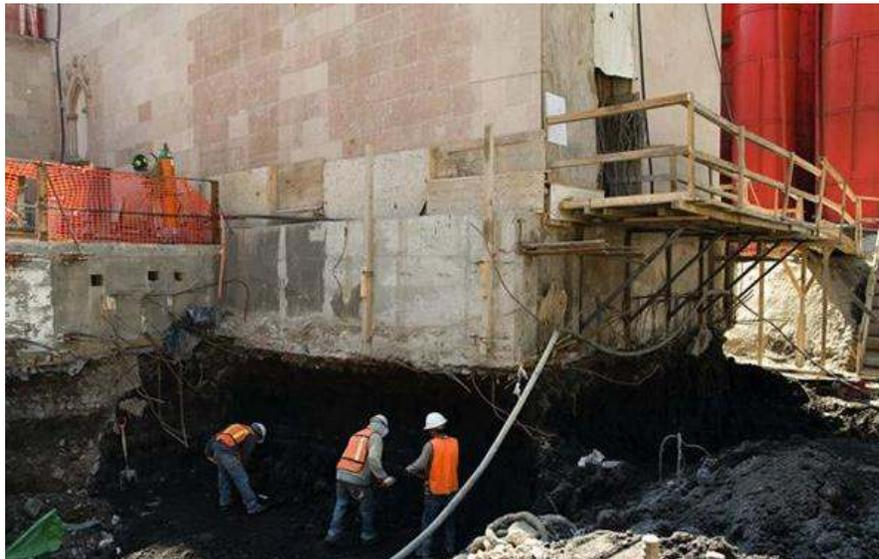
Figura 31a. Excavación a mano bajo la casa.
