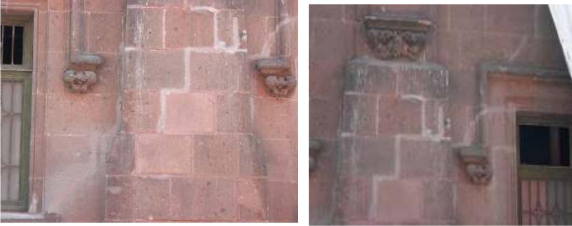
Figura 48. Reparación de agrietamientos mediante mortero.
