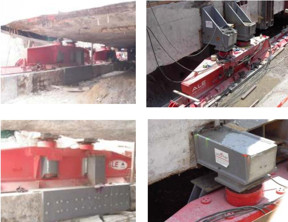
Figura 34. Transmisión de carga hacia los gatos hidráulicos.
