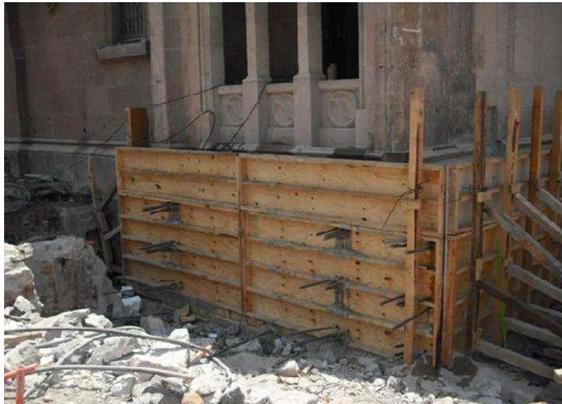
Fig. 23c. Detalle de la cimbra de contacto requerida.
