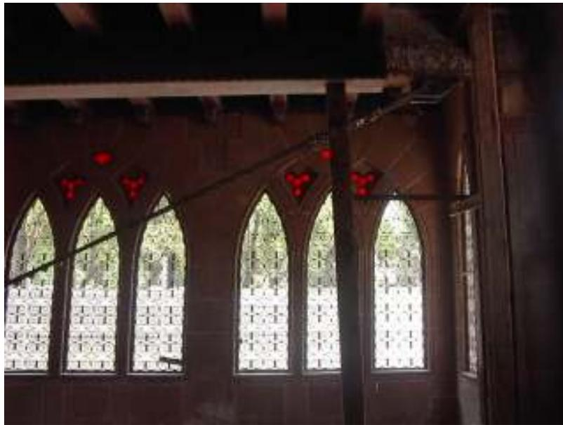
Figura 13. Tensores para rigidizar la estructura.
