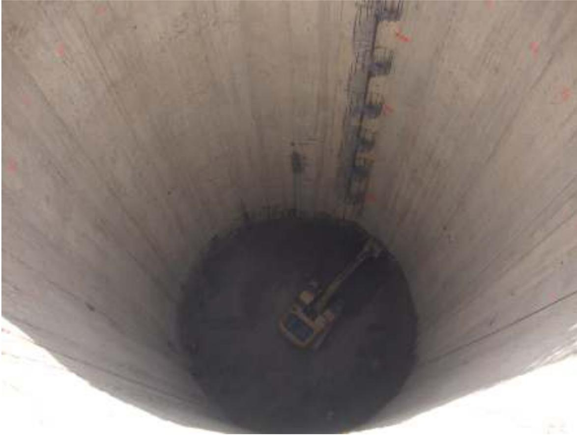
Excavación de Núcleo de lumbrera con avance de 50 m.
