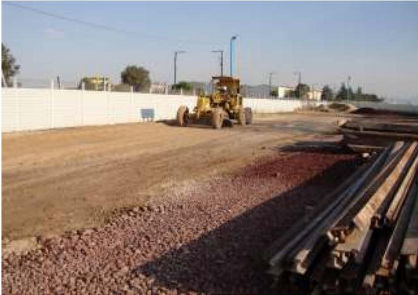
dimensiones del patio de armados serán tales que en él se pueda realizar el habilitado de 2 armados de manera simultánea; la longitud será un poco mayor que la longitud del armado completo para el muro Milán, es decir, se prepara un espacio de 112.0 m como mínimo; el ancho será de 6.0 m. En esta área se
