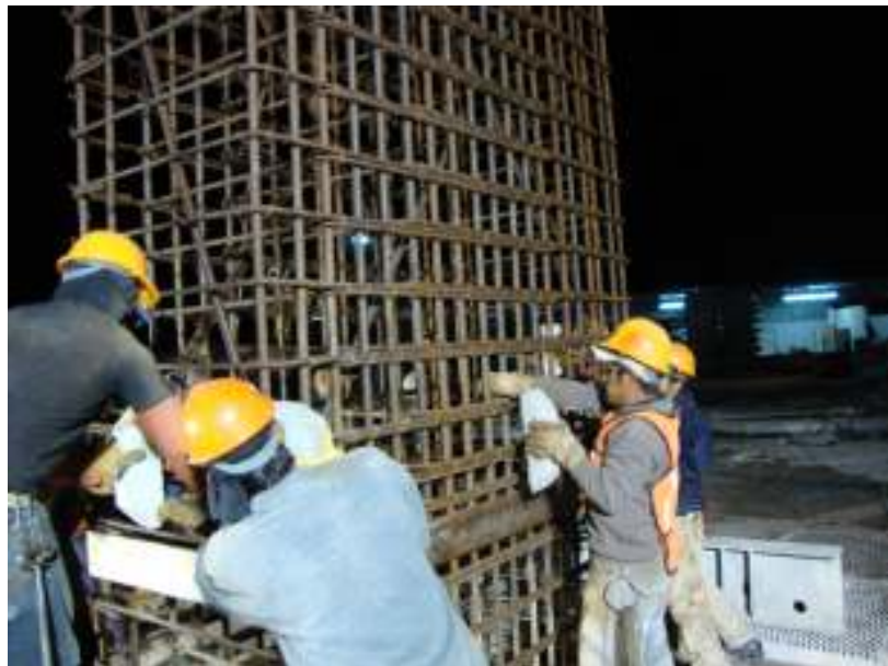
Colocación de separadores de concreto
