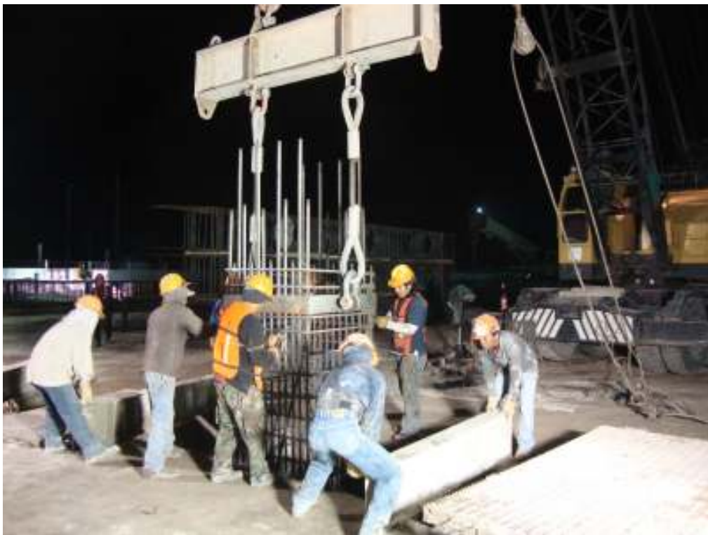
Se coloca módulo 1 sobre vigas de apoyo temporal (armado tipo A-2).
