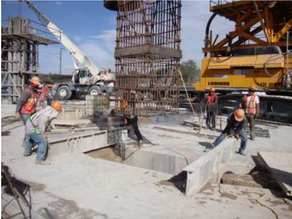
Se realiza inmersión de módulo 1 (armado tipo A-2).
