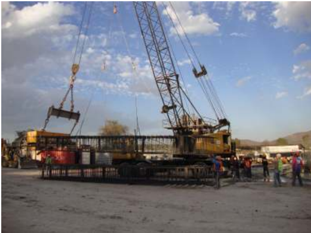
Se realiza el izaje del módulo 1 (armado tipo A-1).
