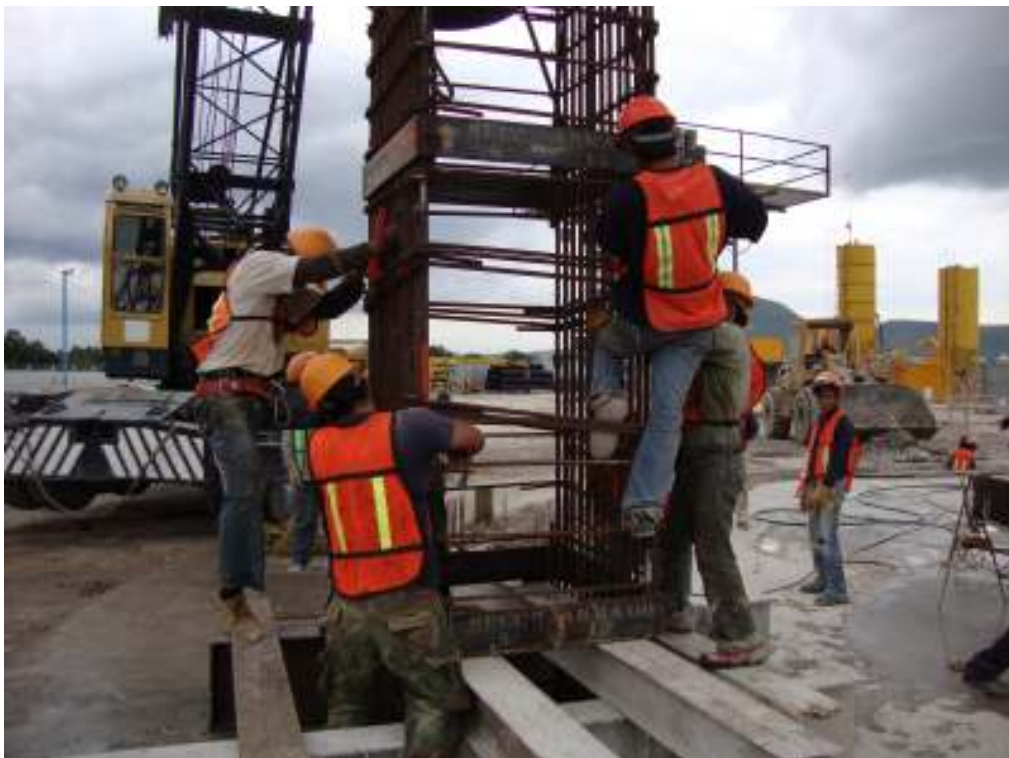
Se realiza el acoplamiento (con conectores mecánicos) de módulos 1 y 2 (armado tipo A-2).
