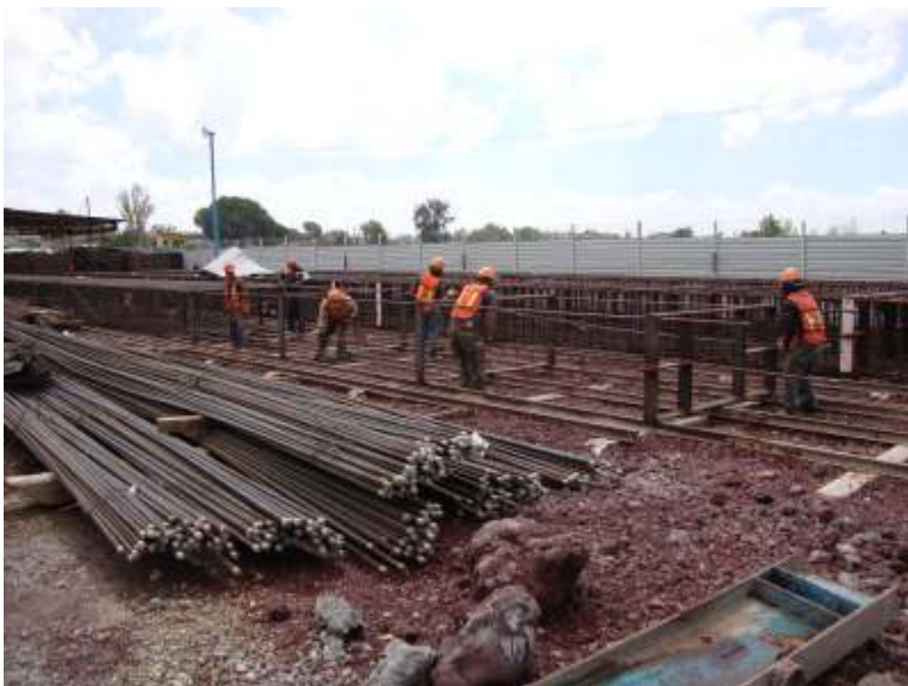
Habilitado de acero de refuerzo utilizando marcos rigidizadores
