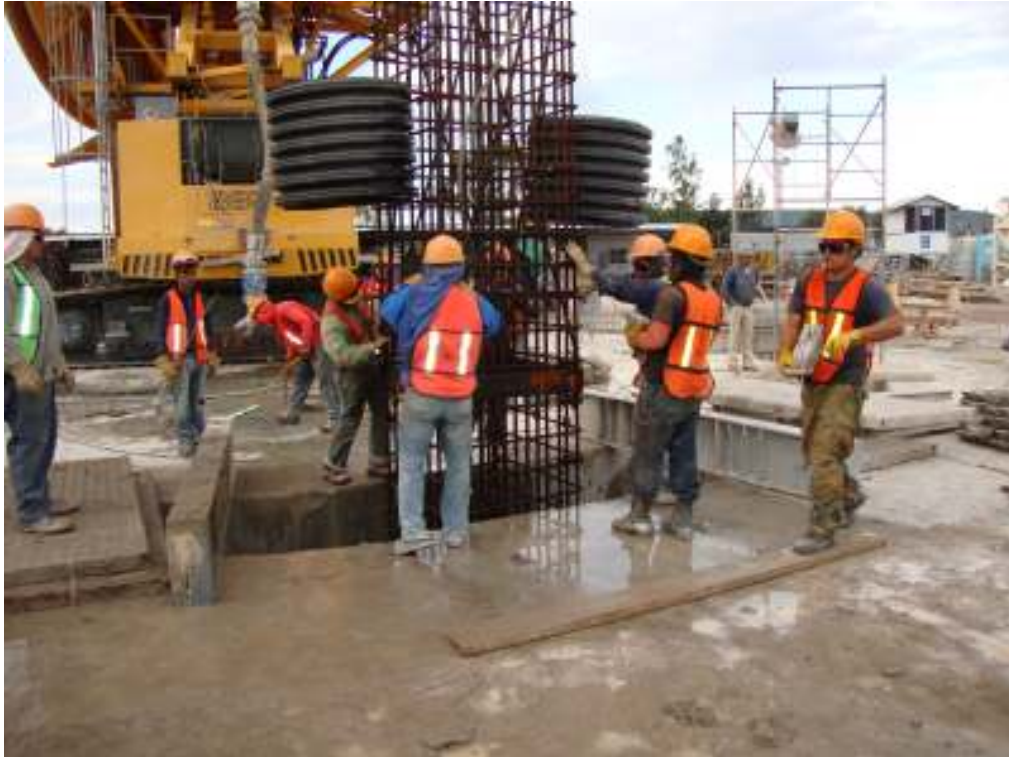
Se realiza izaje e inmersión de módulos siguientes.
