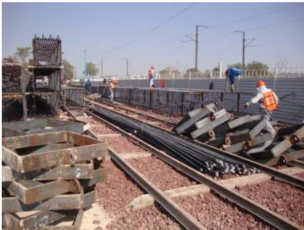
Marcos rigidizadores en patio de habilitado del acero de refuerzo
