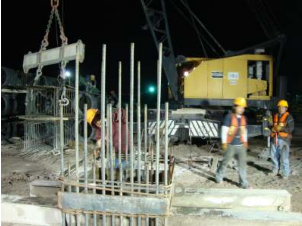
Se tiene módulo 1 apoyado en vigas de soporte temporal. Se sujeta módulo 2 con los dos sistemas de carga de la grúa (armado tipo A-2).
