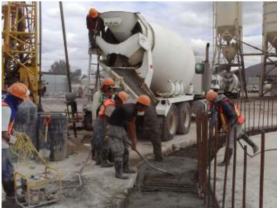
Colocación de concreto y vibrado en trabe de coronamiento.
