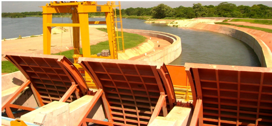
Figura 3.3: Estructura hidráulica de control El Macayo
