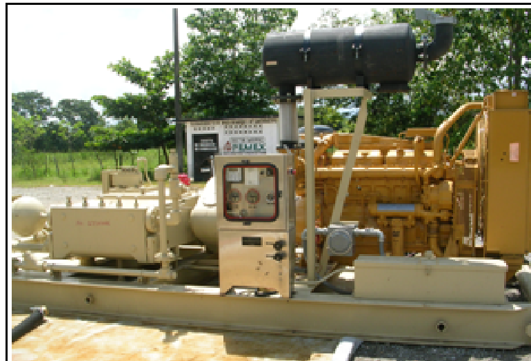
Figura 3.17. Bomba Quintuplex Superficial instalada en el Pozo Secadero 1. 50
