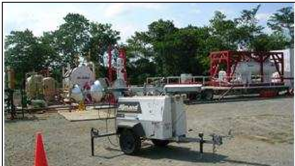
Figura 3.21. Separador Horizontal Trifásico de Alta Presión (adicional), Pozo Secadero 1.
