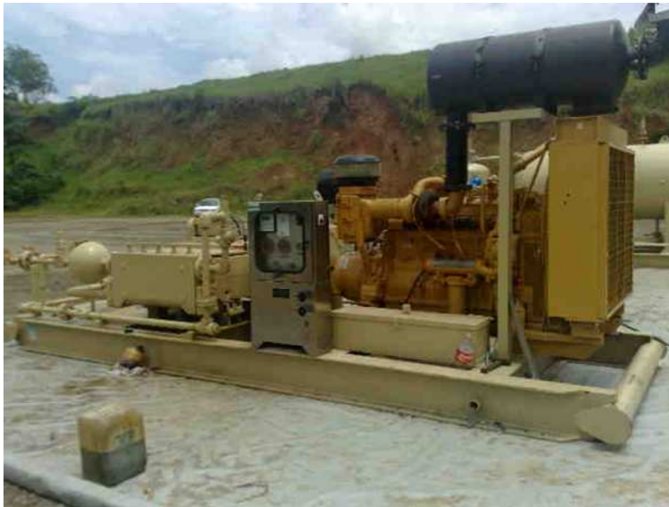
Figura 3.32. Bomba Quintuplex Superficial instalada en el Pozo Secadero 1001. 51
