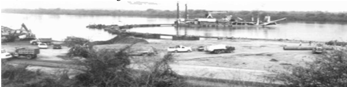
Figura 10, tendido de tubería.
