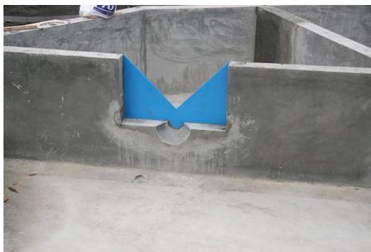
Fig 3.7 Vertedor triangular de pared delgada.
