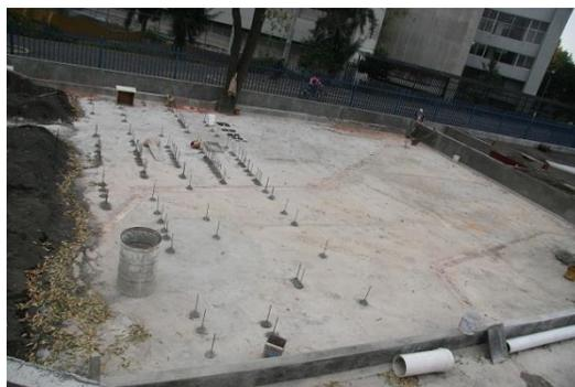
Fig 3.5 Fijación de las varillas.
