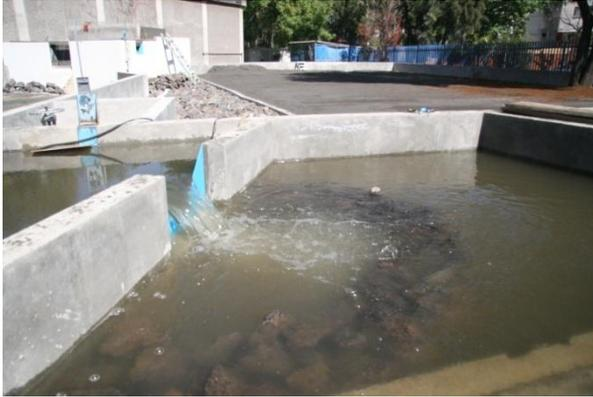
Fig 3.8a Vertedor de pared delgada.
