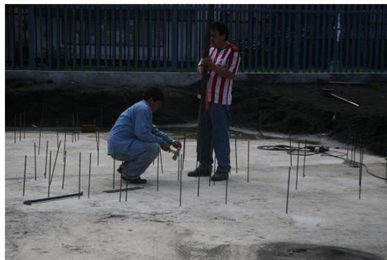
Fig 3.4 Nivelación de la varillas.
