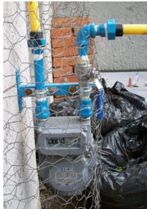
*Figura 4.8 Medidor de gas (Juárez, 2012)*
