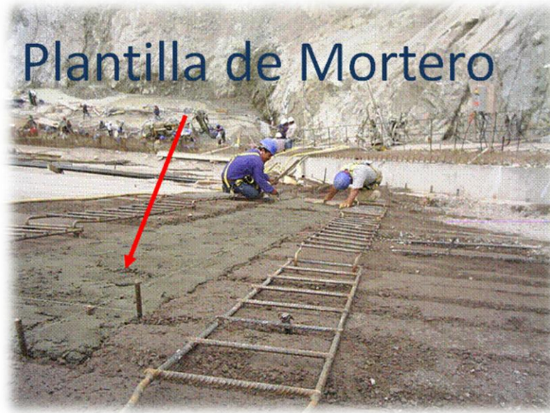
Figura 2.23 Elaboración de la plantilla de mortero.
