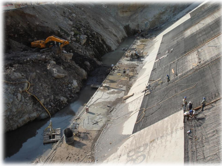
Figura 2.13 Colocación de parrillas de acero de refuerzo
