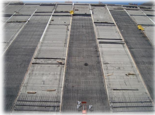
Figura 1.5 Refuerzo de la losa de concreto. P.H. La Yesca
