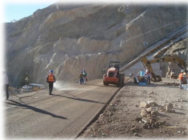
Figura 3.7 Compactaci6n con rodillo liso vibratorio del Material 2 de la cortina de ECC del P.H. La Yesca. La Figura 3.6 muestra la posici6n de este material en la cortina.
