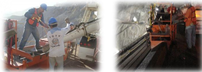
Figura 1.10 Bordillo extruido del P.H. La Yesca
