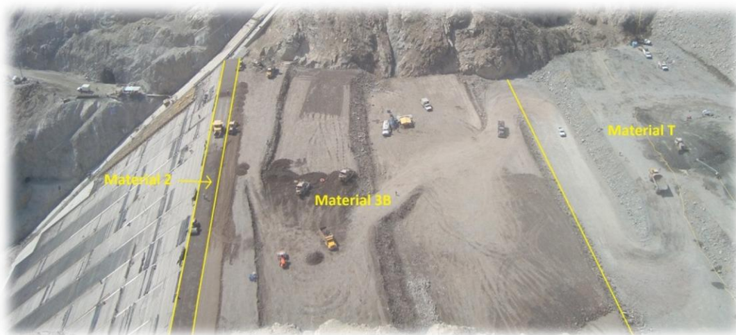
Figura 3.6 Vista de la cortina en dónde se puede apreciar la diferencia entre los materiales 3B y T en el P.H. La Yesca
