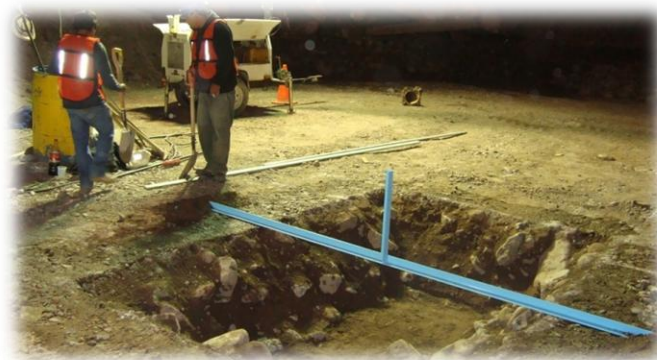
Figura 3.3 Excavaci3n terminada de la prueba Matsuo Akai, puede apreciarse la presencia de finos entre las rocas de aluvi3n
