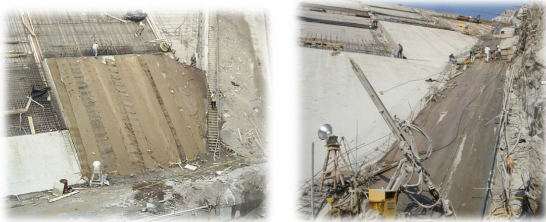
Figura 1.6 Losas de arranque P.H. La Yesca
