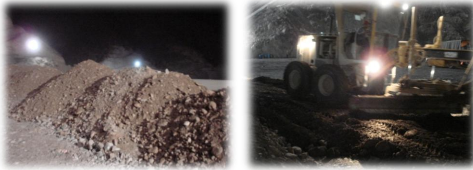
Figura 3.15 Material 3B cribado colocado en montículos (izquierda) y motoconformadora esparciendo el material (derecha).
