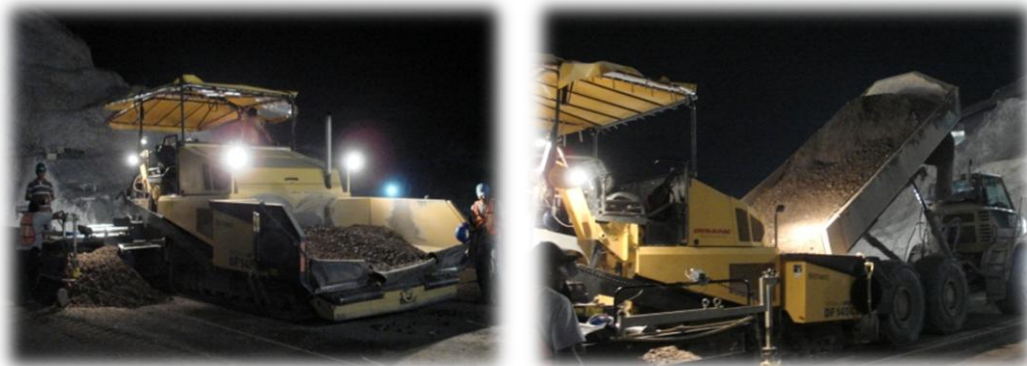
Figura 3.11 Esparcidora Finisher, utilizada en la colocación del material 2 con excelentes resultados en el P.H. La Yesca
