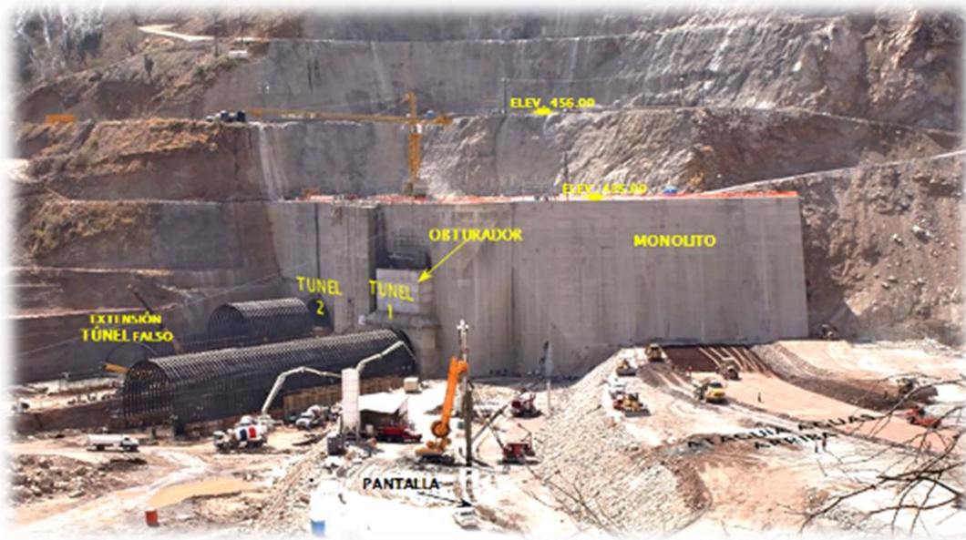
Figura 3.21 Monolito y túnel falso en el portal de entrada de los túneles de desvío.
