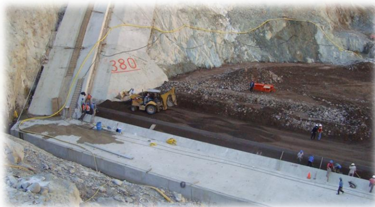
Figura 1.2 Plinto en una etapa de construcción temprana del cuerpo principal de la cortina P.H. La Yesca
