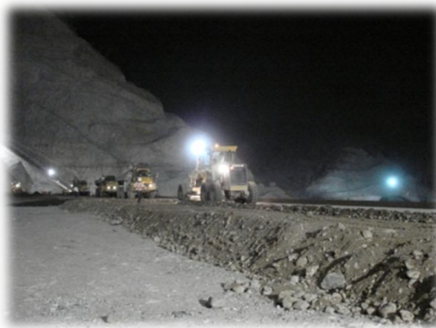
Figura 3.16 Material 3B cribado colocado, antes de ser compactado.
