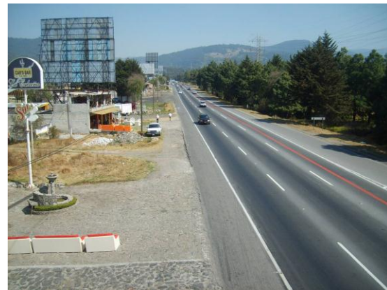
Fotografías 4.2.7 y 4.2.8 Señalamiento horizontal: vialetas y raya de rampa de frenado
