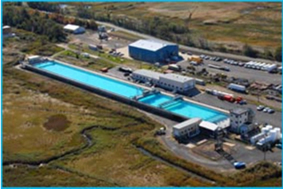
Figura 5-21 Canal de arrastre en las instalaciones de Ohmsett, New Jersey USA
