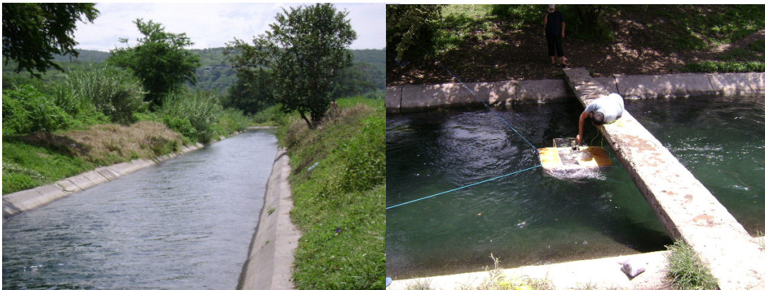
Figura 5-22 Canal en las Estacas, Morelos
