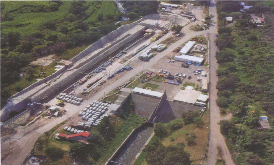
PORTALES DE SALIDA DEL TUNEL EMISOR CENTRAL (LADO DERECHO) Y DEL TUNEL EMISOR ORIENTE EN CONSTRUCCION (LADO IZQUIERDO)
