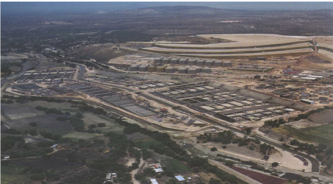
PLANTA DE TRATAMIENTO DE AGUAS RESIDUALES ATOTONILCO (EN CONSTRUCCION)
