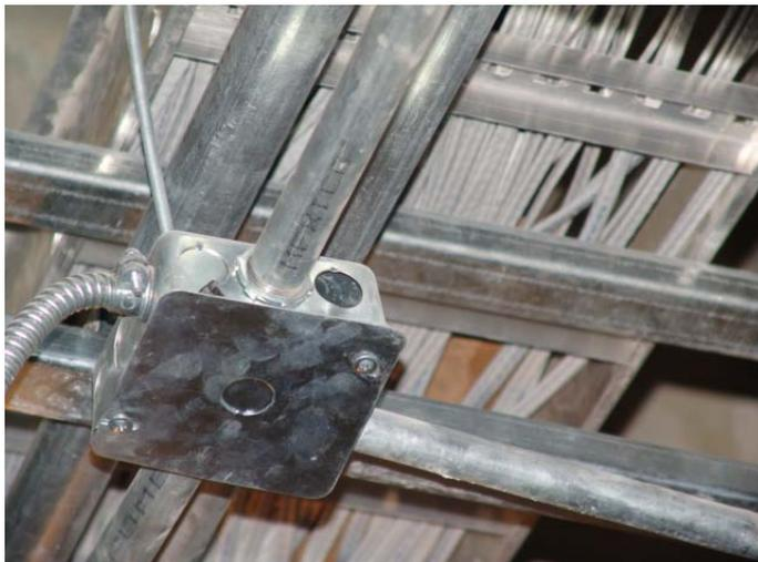
Fotografía donde se ve la caja, tubería, contra y monitor
