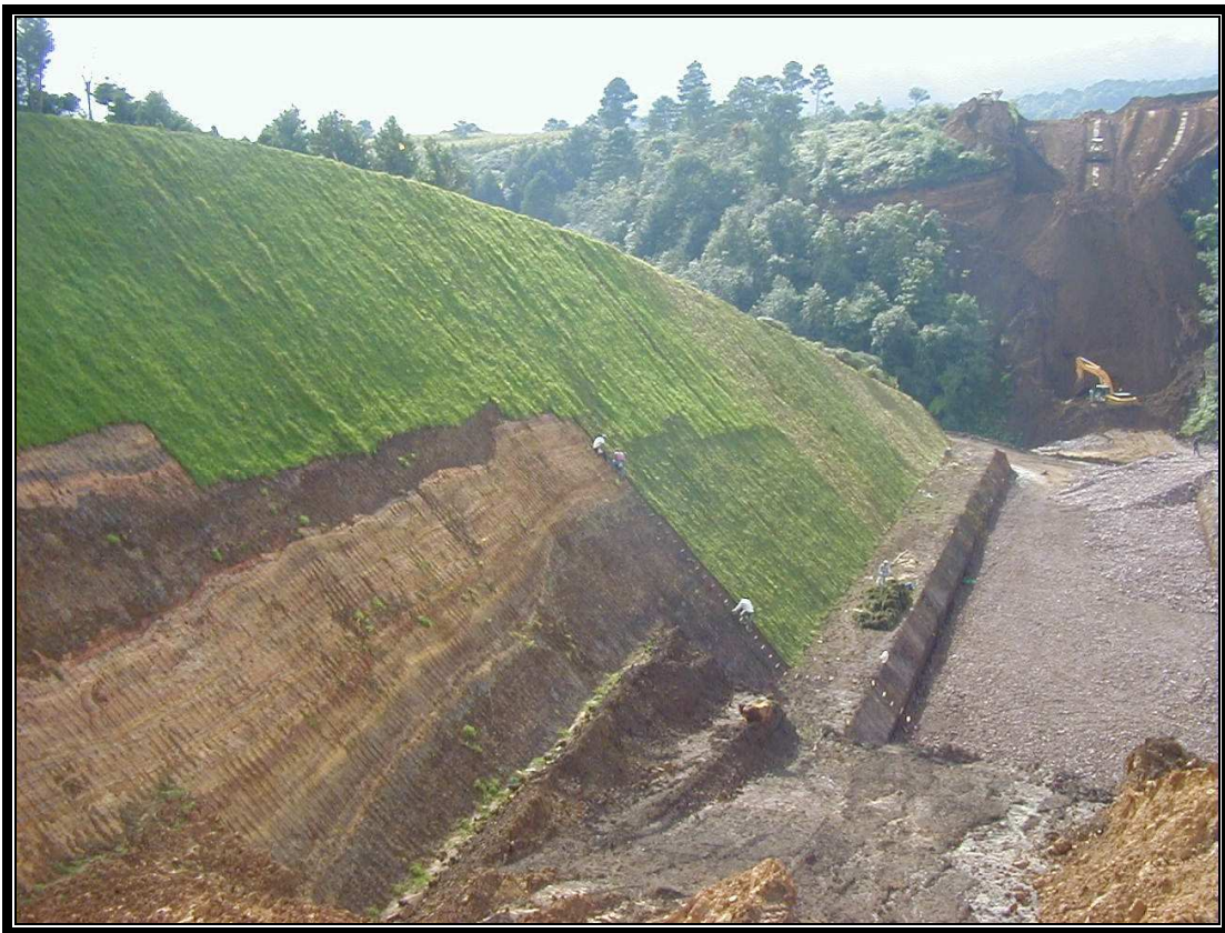
FIGURA 35. PASTO EN TALUDES.
