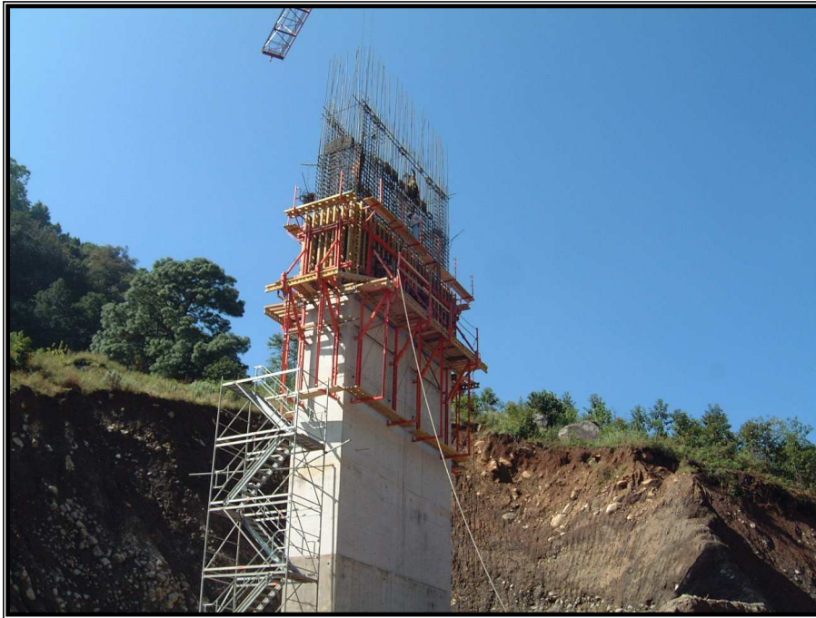
FIGURA 26. CIMBRA TREPADORA COLOCADA EN PILA.
