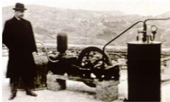
Figura 1.11 Primera central geotérmica (Solielima.es, 2011)
