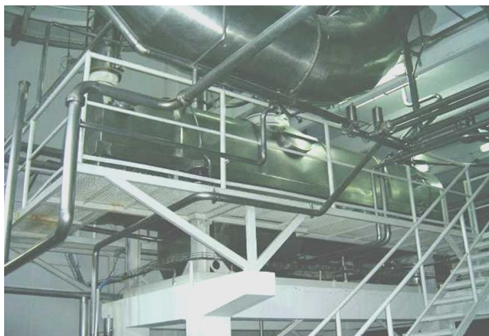
Figura 2.8 Vibrofluidizador (Rodrigo, 2011)
