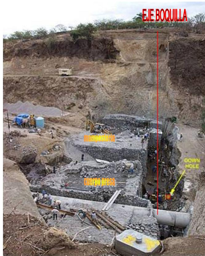
**Fotografía 6. Posición del Sondeo (AL-6) en donde se realizó el Down-hole**
