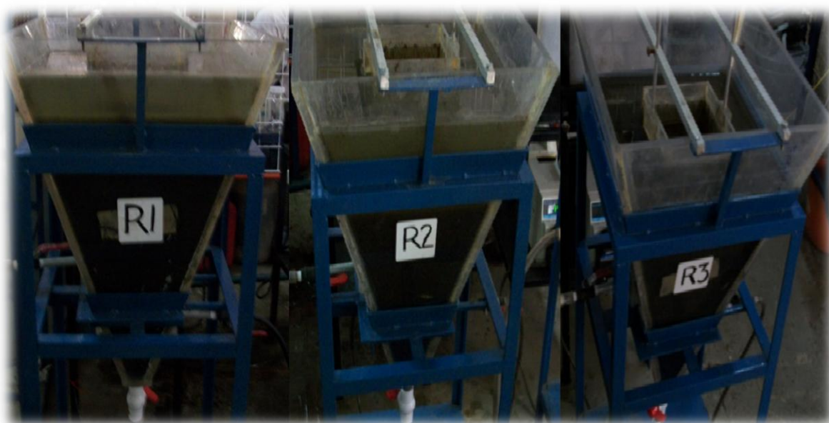
Foto 4.2. Vista frontal de los sedimentadores secundarios
