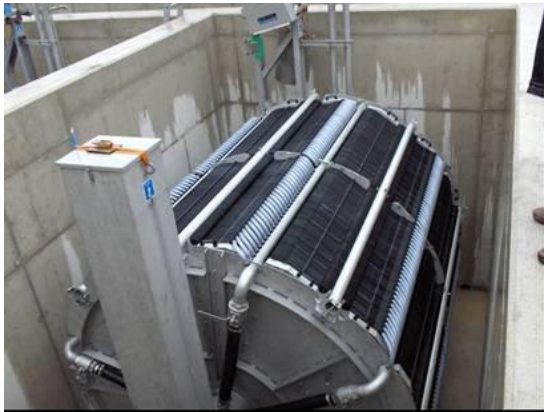
Figura AI.13 Unidad de membranas
