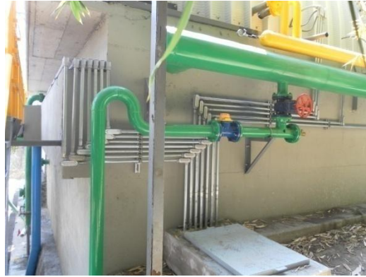
Figura AII.6 Medidor del volumen de purgas
