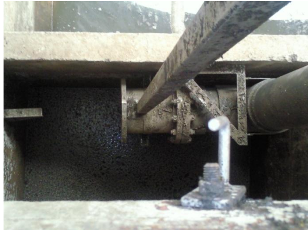
Figura AI.12 Accesorio de acoplamiento a la bomba de alimentación del de membranas.
