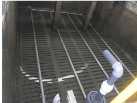
Figura AI.8 Arreglo de difusores tubulares.
