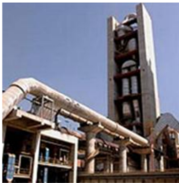
Figura 12. Edificio precalentador de ciclones.
