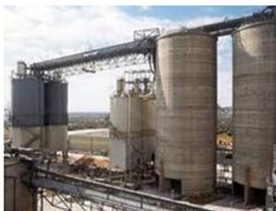
Figura 16. Silos de almacenamiento de cemento.
