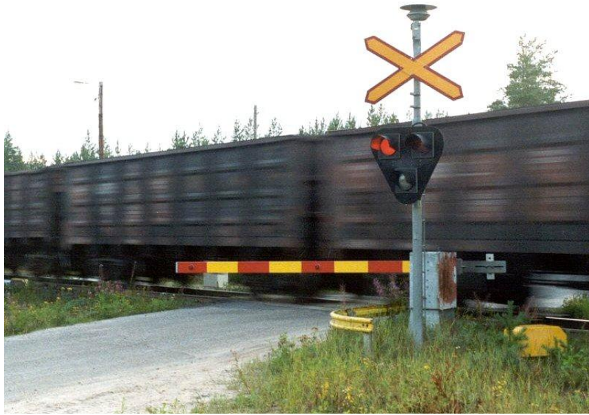
ILUSTRACIÓN 6: PASO A NIVEL CON SEÑALAMIENTO Y PLUMA.
