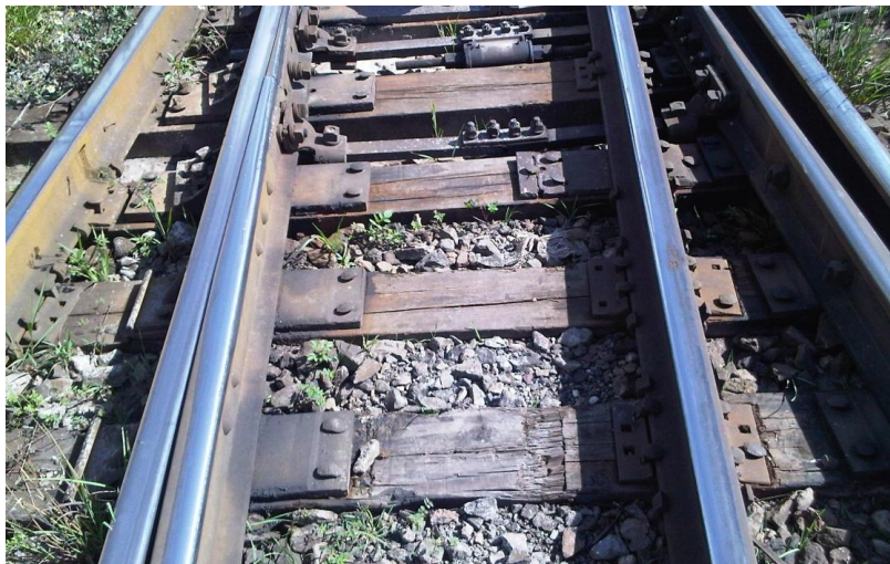
ILUSTRACIÓN 2: VISTA SUPERIOR DE AMBOS RIELES SOBRE DURMIENTES DE MADERA
