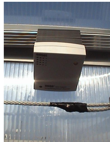
b) Sensores de temperatura (2), luminosidad, y humedad relativa
