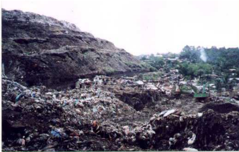
Figura 3.9 Vista general del deslizamiento de Payatas (Koelsch, 2000)
