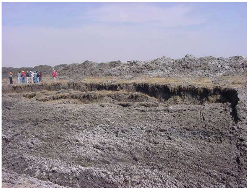
Figura 3.16 Dren Alterno. Falla de talud con pendiente pronunciada (Fotografía proporcionada por el Dr. Gabriel Auvinet)
