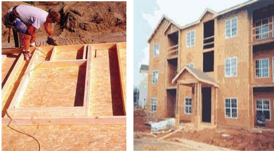
Figura 43. Paneles forrados con tableros de fibras orientadas, Oriented Strand Board (OSB).
