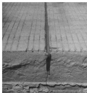
Fig. 3.3. Sellado de juntas.
