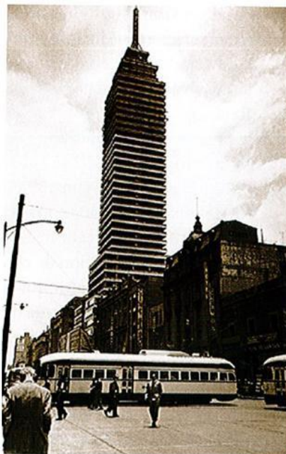
FIGURA 69. TORRE LATINOAMERICANA EN CONSTRUCCIÓN. AUVINET GUICHARD.
