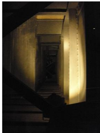
FIGURA 60. PARRILLA DE ACERO EN CIMENTACIÓN DEL MONUMENTO A LA REVOLUCIÓN. MARTÍNEZ OVIEDO.
