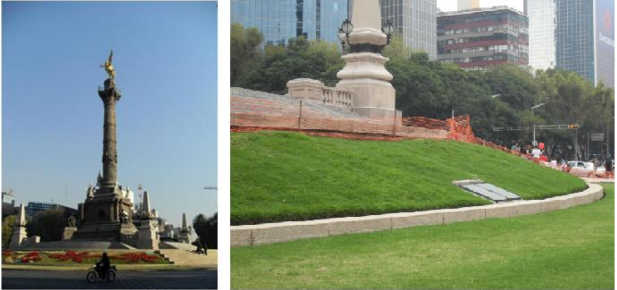
FIGURA 50. MONUMENTO EN LA ACTUALIDAD Y DETALLE TALUD AJARDINADO PARA DESNIVEL POR HUNDIMIENTO REGIONAL. MARTÍNEZ OVIEDO.
