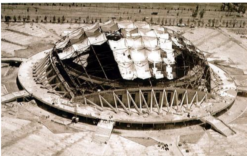
FIGURA 71. PALACIO DE LOS DEPORTES DURANTE SU CONSTRUCCIÓN. AUVINET GUICHARD.
