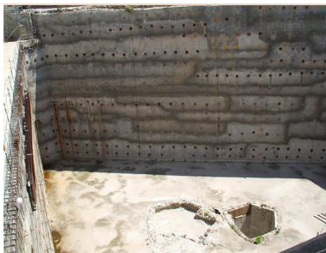
FIGURA 74. EXCAVACIÓN DE LA CIMENTACIÓN DE LA TORRE MAYOR. OSCAR HENRY.
