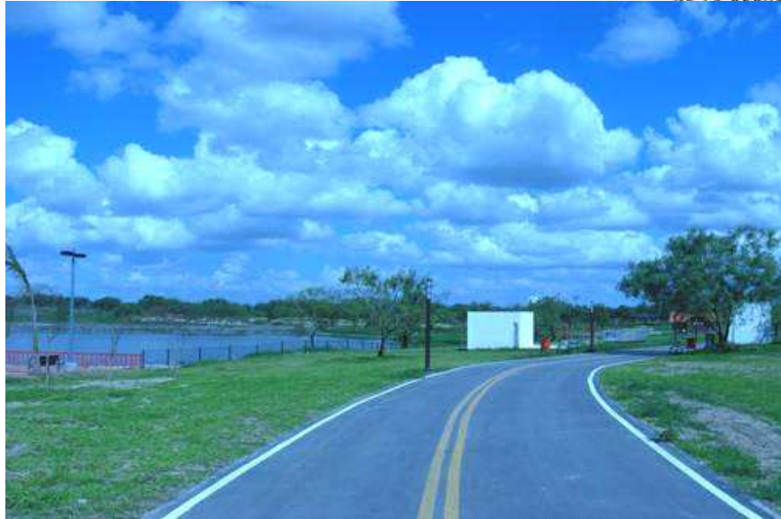
INSTALACIONES EN FUNCION DENTRO DE LA ZONA INVADIDA
