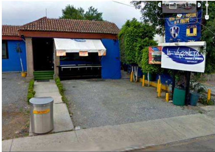
ASPECTO GENERAL DE LA FACHADA PRINCIPAL SOBRE RIO AMAZONAS, EN SAN PEDRO GARZA
