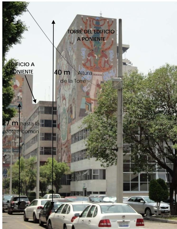
Figura 3.28 Configuración del edificio A Poniente
