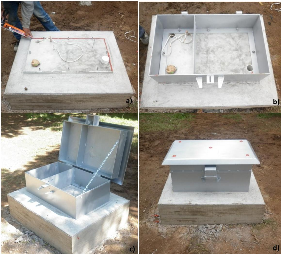
Figura III.16. Ensamble de la caja metálica
