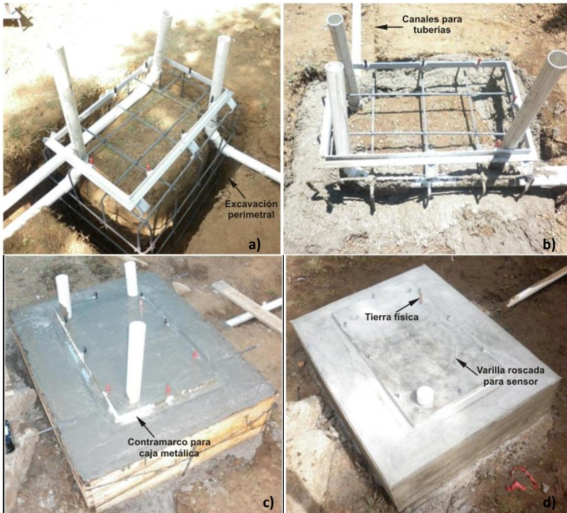
Figura III.14. Proceso constructivo de la base concreto
