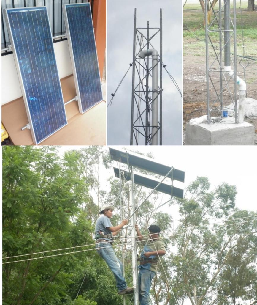
**Figura III.20.**Colocación de celdas solares
