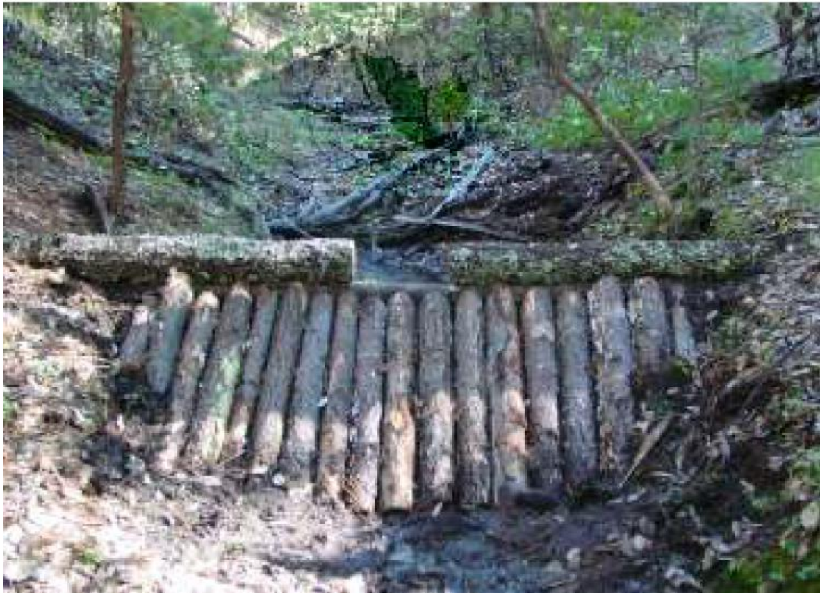
Figura 7.46 Presa de morillo. (CONAFOR, 2004)
