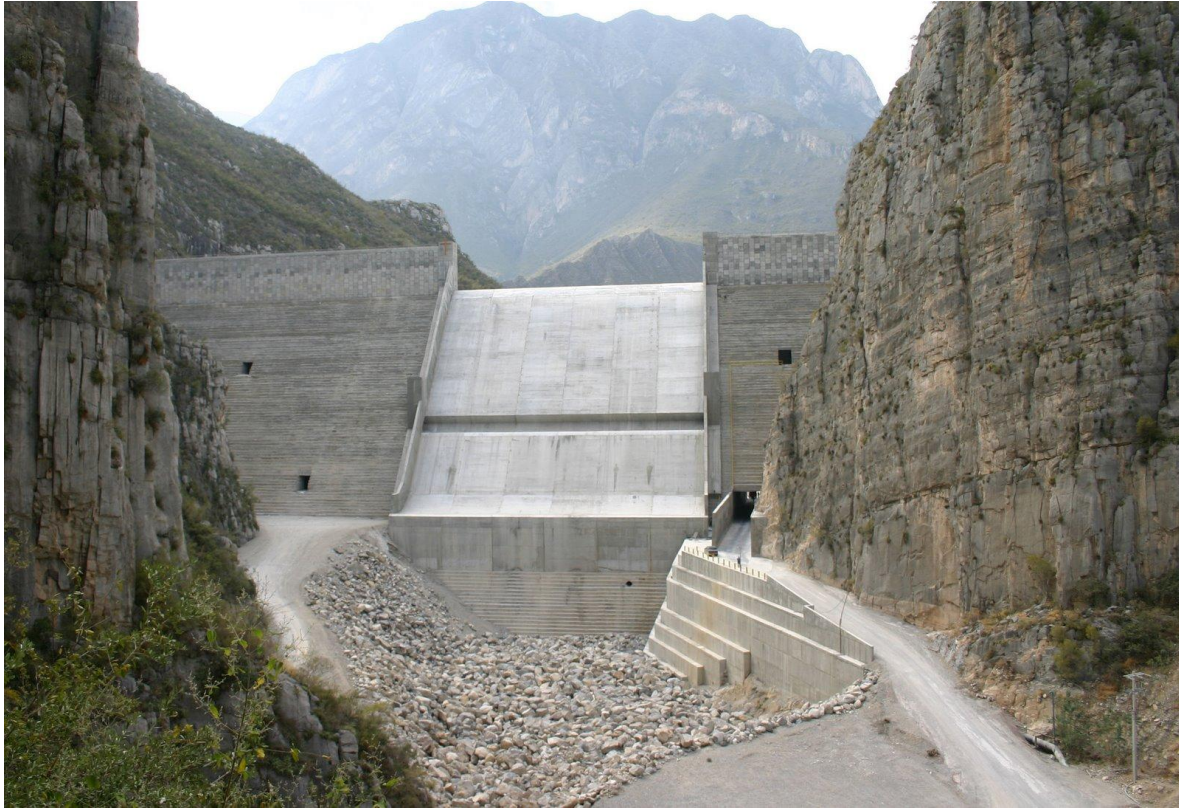
Figura 7.38. Presa rompe-picos del río Santa Catarina, Monterrey
