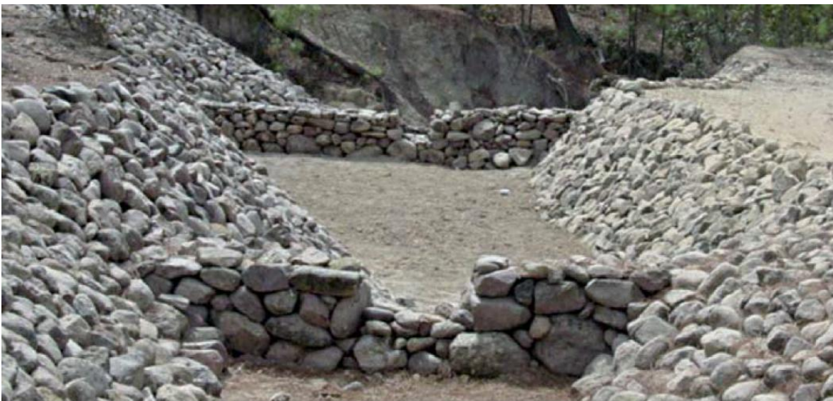
Figura 7.52. Estabilización de talud con piedra. (CONAFOR, 2007)
