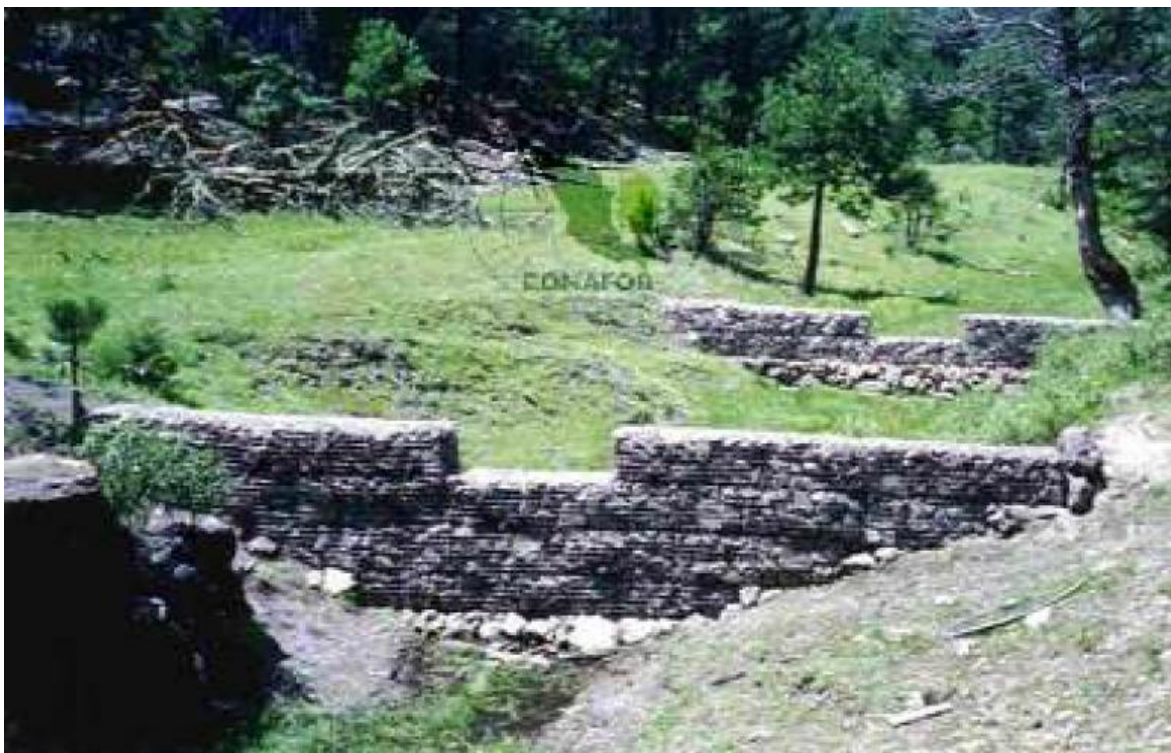
Figura 7.45. Presas de malla electro-soldada o ciclónica. (CONAFOR, 2004)
