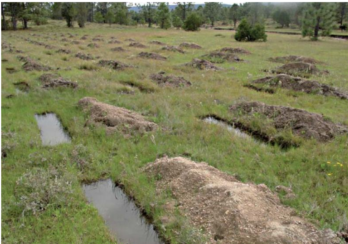
Figura 7.57. Zanjas trinchera. (CONAFOR, 2007)
