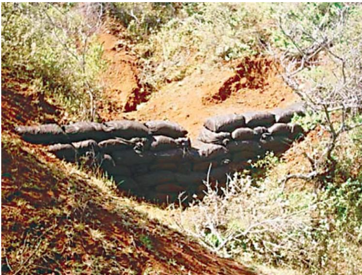
Figura 7.50. Presas de geocostales. (CONAFOR, 2007)
