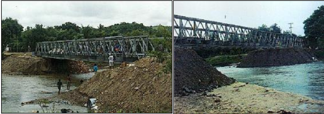
Figura 7.68. Puentes tipo Mabey. (SCT,2011)
