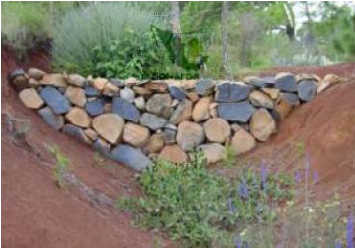
Figura 7.48. Presas de piedra acomodada. (CONAFOR, 2004)
