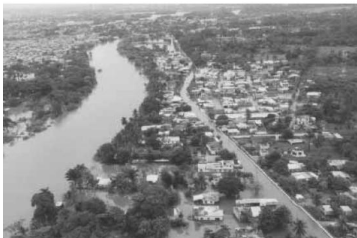
Figura 5.1. Vista inundación en la ribera del río Carrizal, al oeste de Villahermosa.
