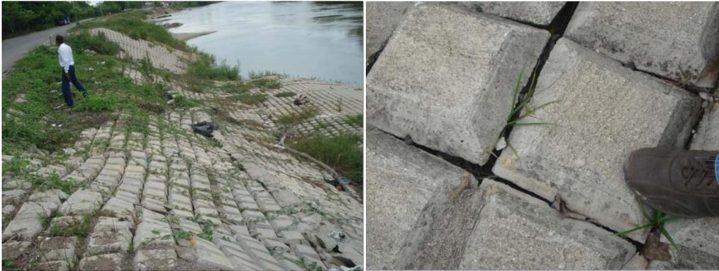
**Figura 4.7 Deslizamiento del terraplén como consecuencia de deformaciones debidas a la filtración de agua en la ladera. Villahermosa, Tabasco.**
