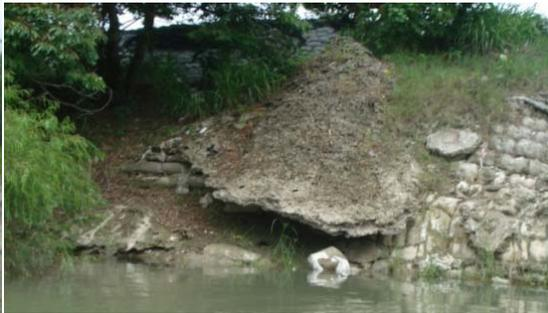
**d) Socavación vista en recubrimiento de concreto**
