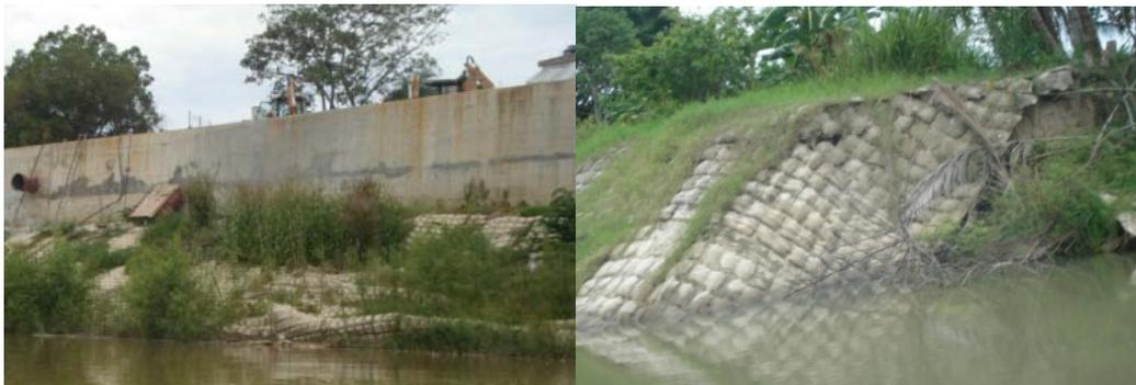
a) Bordo con muro en su corona      b) Falla de talud y desprendimiento de colcha
