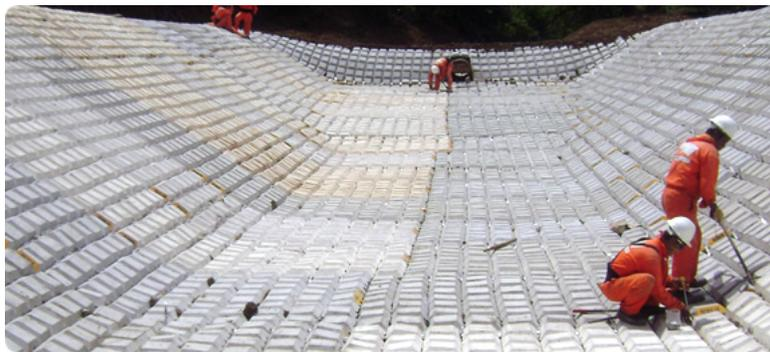
*Figura 3.1 Colocación de tapete flexible en todo el cana, (Sub Marelher, 2001).*
