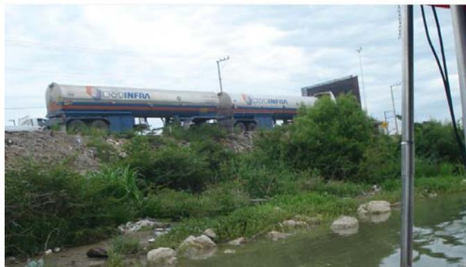
*Figura 4.2 Exceso de carga en un bordo. Villahermosa, Tabasco.*
