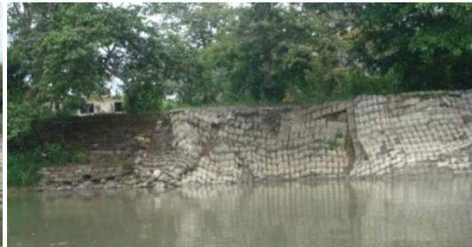
**b) Falla de talud y rotura de la colcha**
