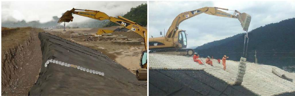
*Figura 8.2. Colocación de tapetes flexibles, (Sub Marelher, 2001)*
