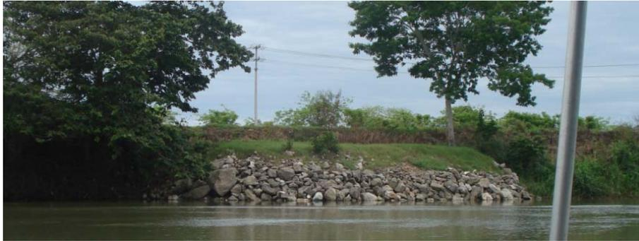
*Figura 4.8. Bordo con falla por asentamiento. Villahermosa, Tabasco.*
