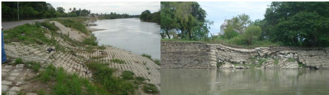
c) Bordo con deformación      d) Falla de talud con costales de concreto en la corona
