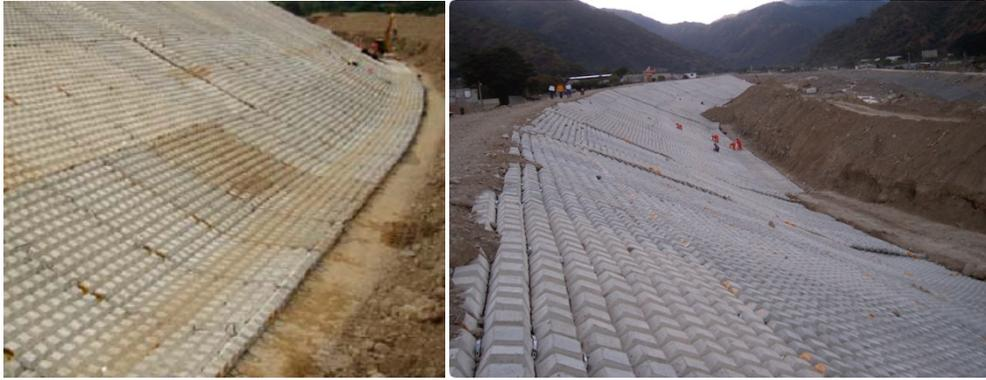
**Figura 8.3. Sección final de los tapetes dentro del cauce, (Sub Marelher, 2001).**
