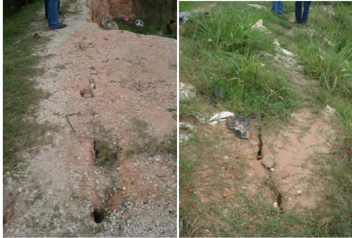
*Figura 4.6 Grietas longitudinales producidas en un Bordo. Villahermosa, Tabasco.*
