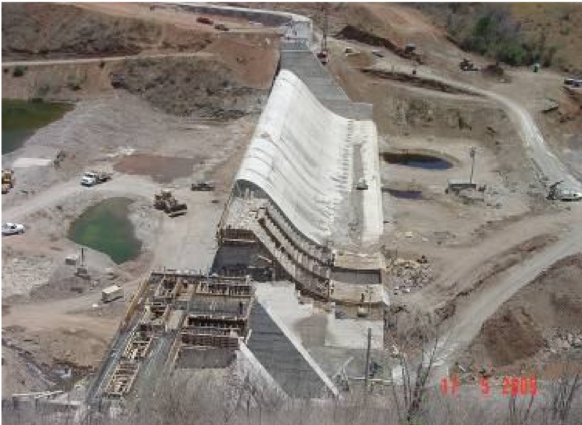
Imagen 8.- P.R. Amata, Estado de Sinaloa. Presa de CCR
