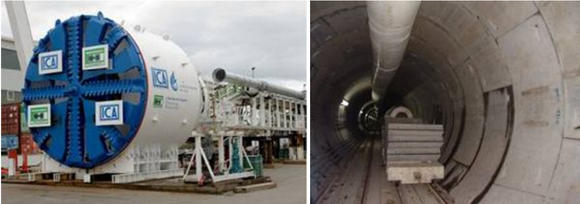
Imagen 16.- Excavación con Tunnel Boring Machine y dovelas
