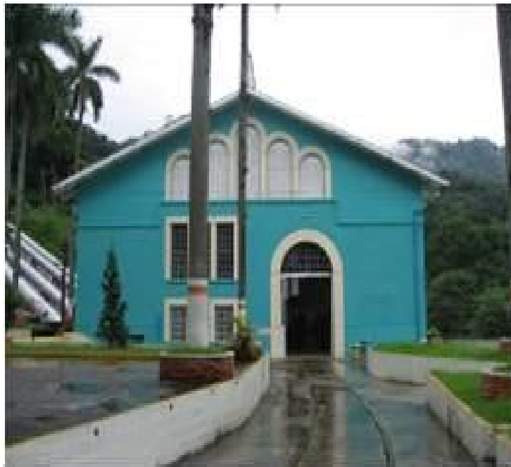
Imagen 18.- C.H. Tuxpango, Estado de Veracruz. Casa de máquinas superficial
