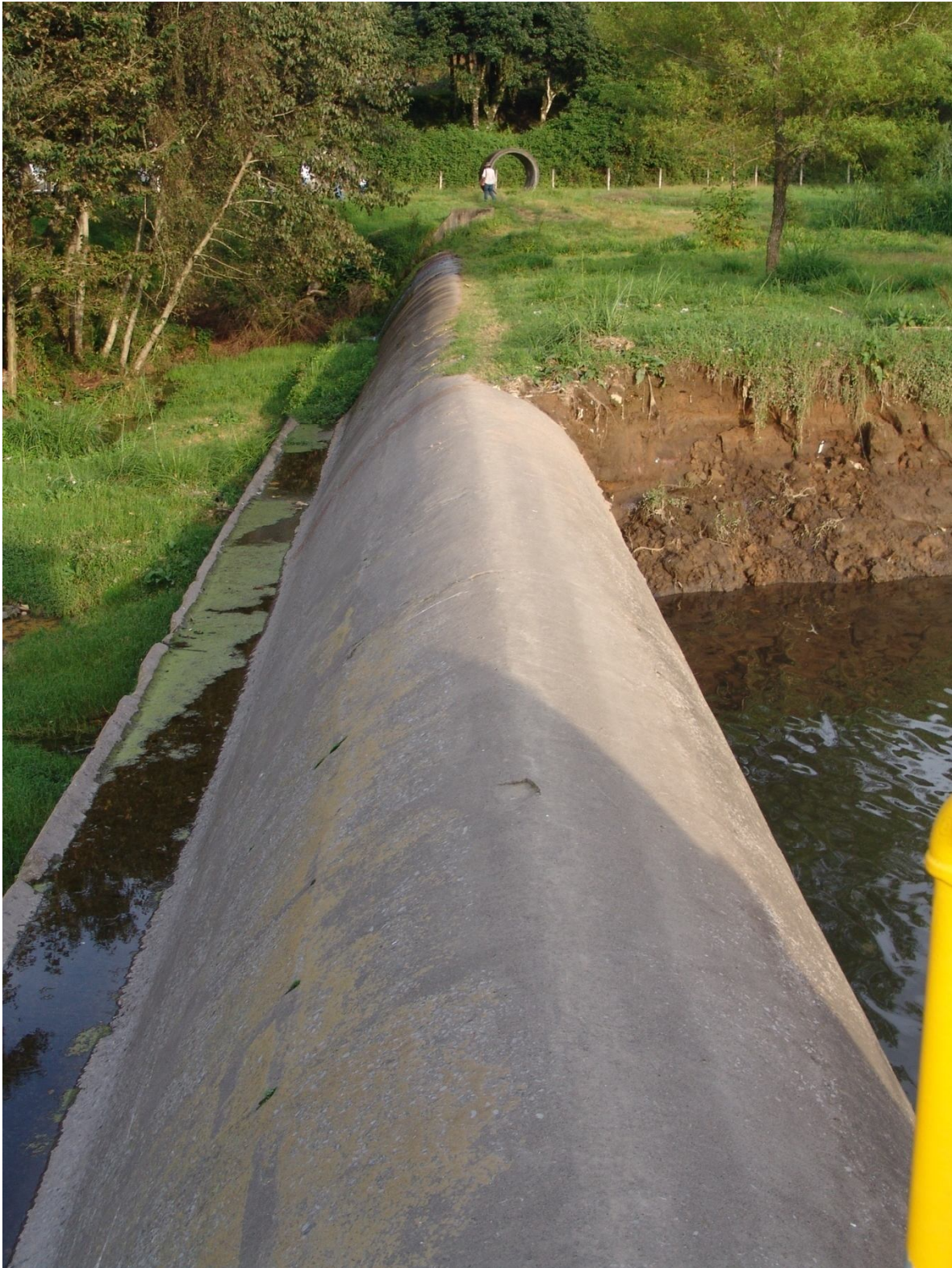
Imagen 5.- P.D. Acateno II, Estado de Puebla. Presa rígida
