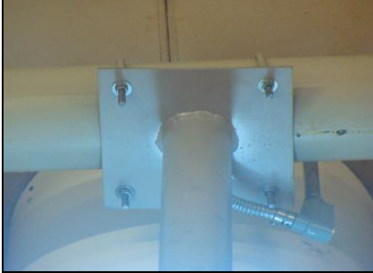
Figura 3.16. Montaje especial del soporte hexagonal.
