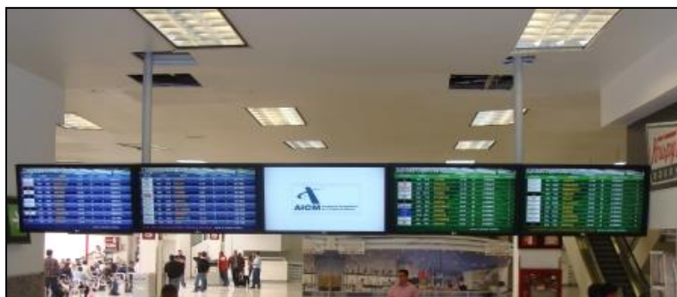
Figura 3.2. Soporte Larguero para 5 o 10 pantallas, en la imagen es el caso de 5 pantallas con sujeción a techo. Archivo interno de DIMITEC.
