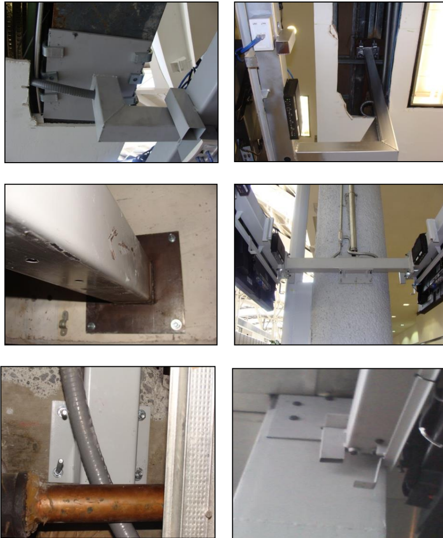
Figura 3.21. La figura muestra los diferentes montajes, todos a partir de un larguero universal para las diferentes configuraciones. Dependiendo el lugar de fijación es el tipo de montaje.
