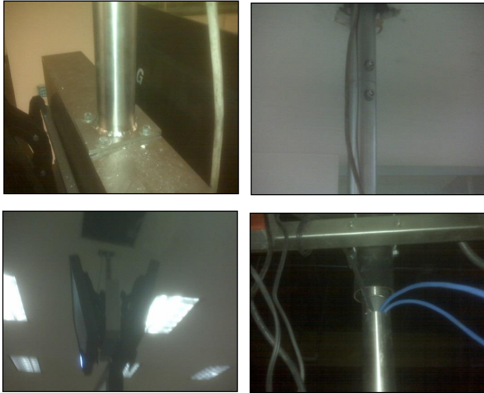
Figura 3.27. La figura muestra a detalle el ensamble del tubular con la caja, así como la sujeción a techo.
