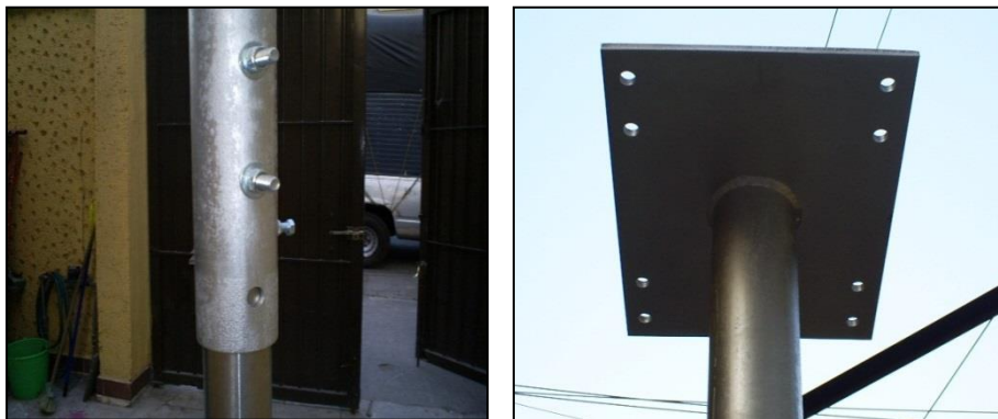
Figura 3.14. La figura muestra el soporte diseñado para la sujeción a techo, en este caso a plafón forjado
