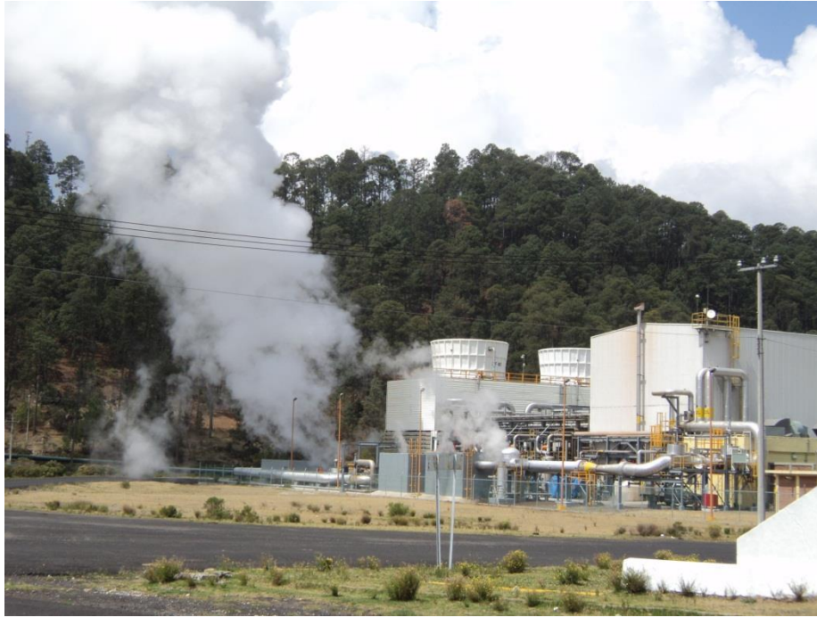
Figura 10. Central de generación geotérmica “Los Azufres” CFE
