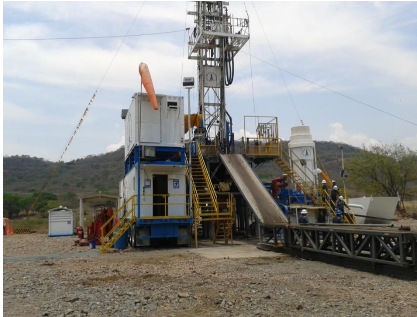
Figura 21.- Equipo de perforación
