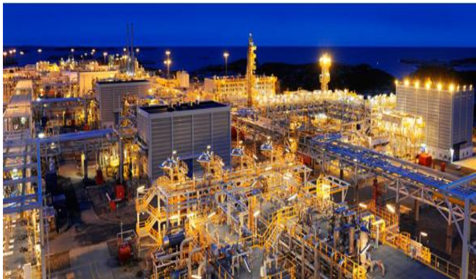
Figura 4.58 Planta procesadora de gas, Kollsnes
