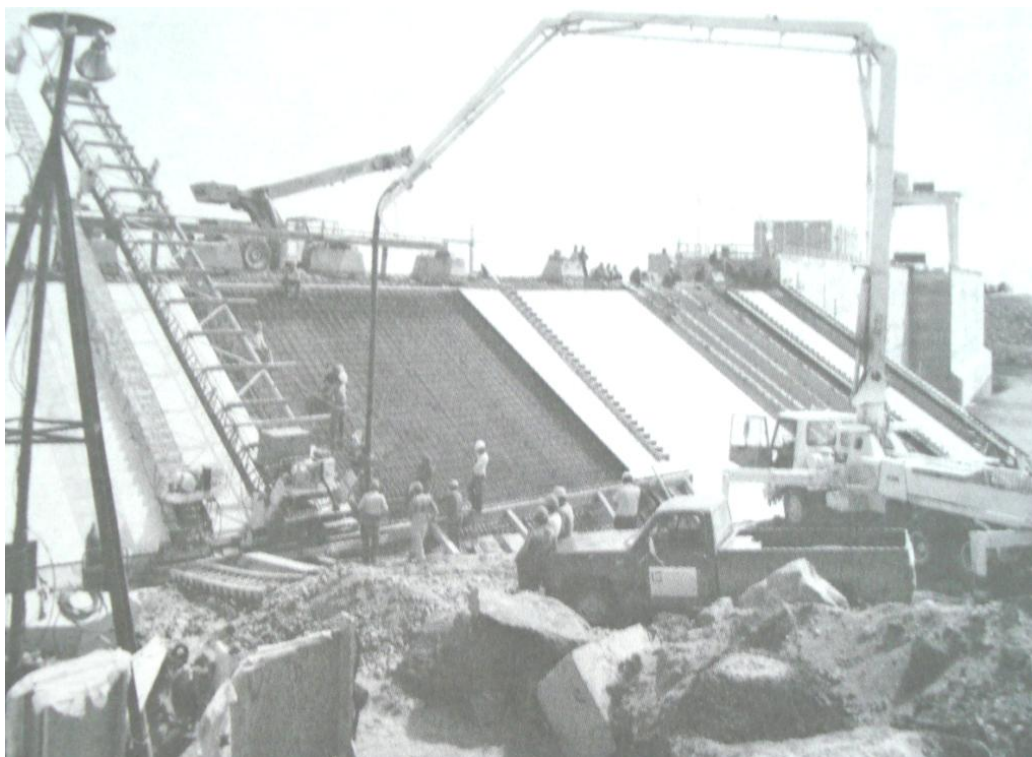
Figura 5.5.1.2 Construcción de una cortina de ECC, Referencia 1
