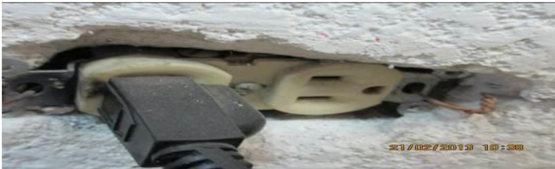
***Ilustración 40. Contacto mal colocado, sin tapa y espacio sin resanar***
