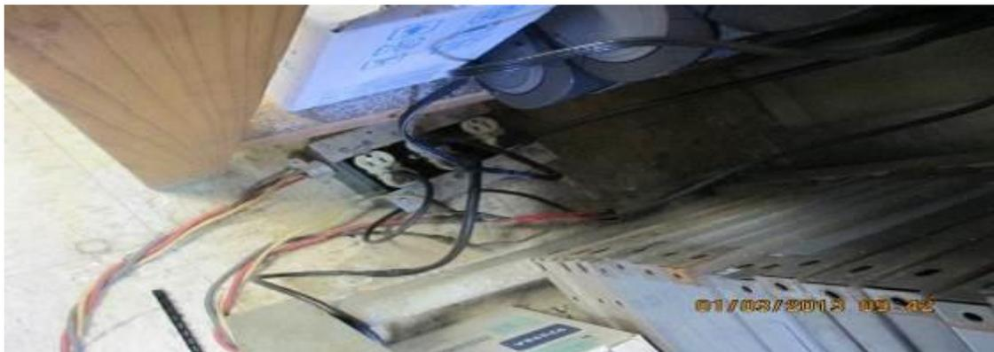
***Ilustración 54. Uso de contactos provisionales y sin protección***
