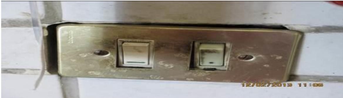
***Ilustración 18. Apagador mal empotrado***
