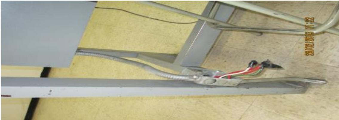
***Ilustración 50. Caja sin tapa y empalmes expuestos***
