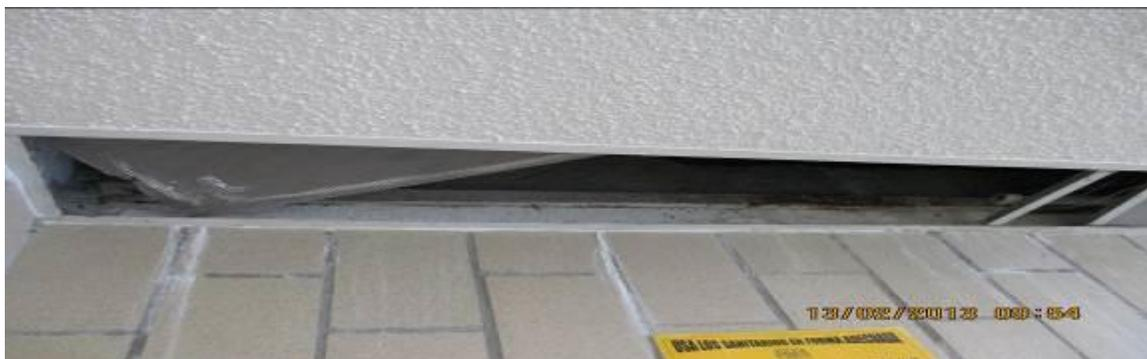
**Ilustración 16. Difusor roto y mal colocado**
