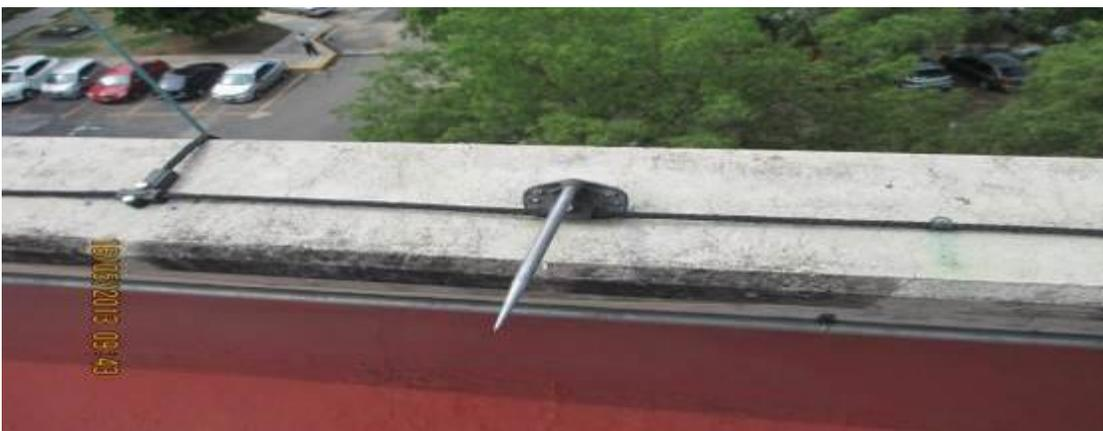
***Ilustración 75. Punta de pararrayos sin sujetar***
