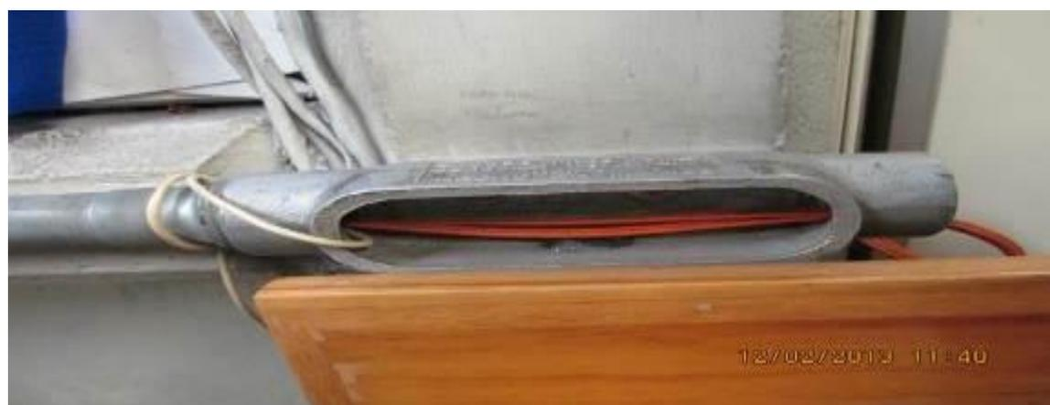
***Ilustración 14. Canalización incompleta y sin tapa***
