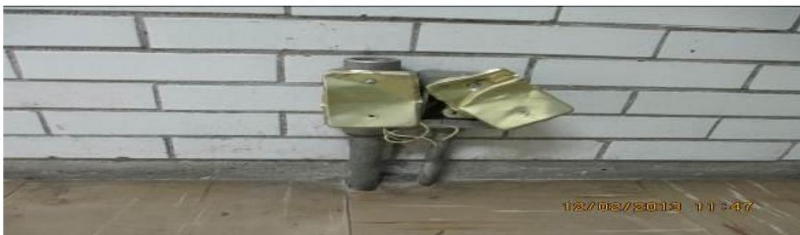
**Ilustración 17. Tapas dañadas y cable expuesto**
