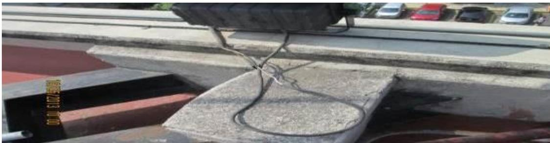
***Ilustración 81. Cables sin protección y falta de conexión a tierra***
