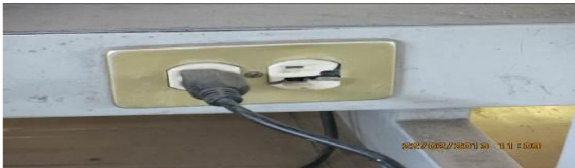
***Ilustración 33. Contacto en mal estado***
