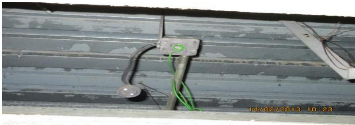
***Ilustración 61. Cables sin protección***
