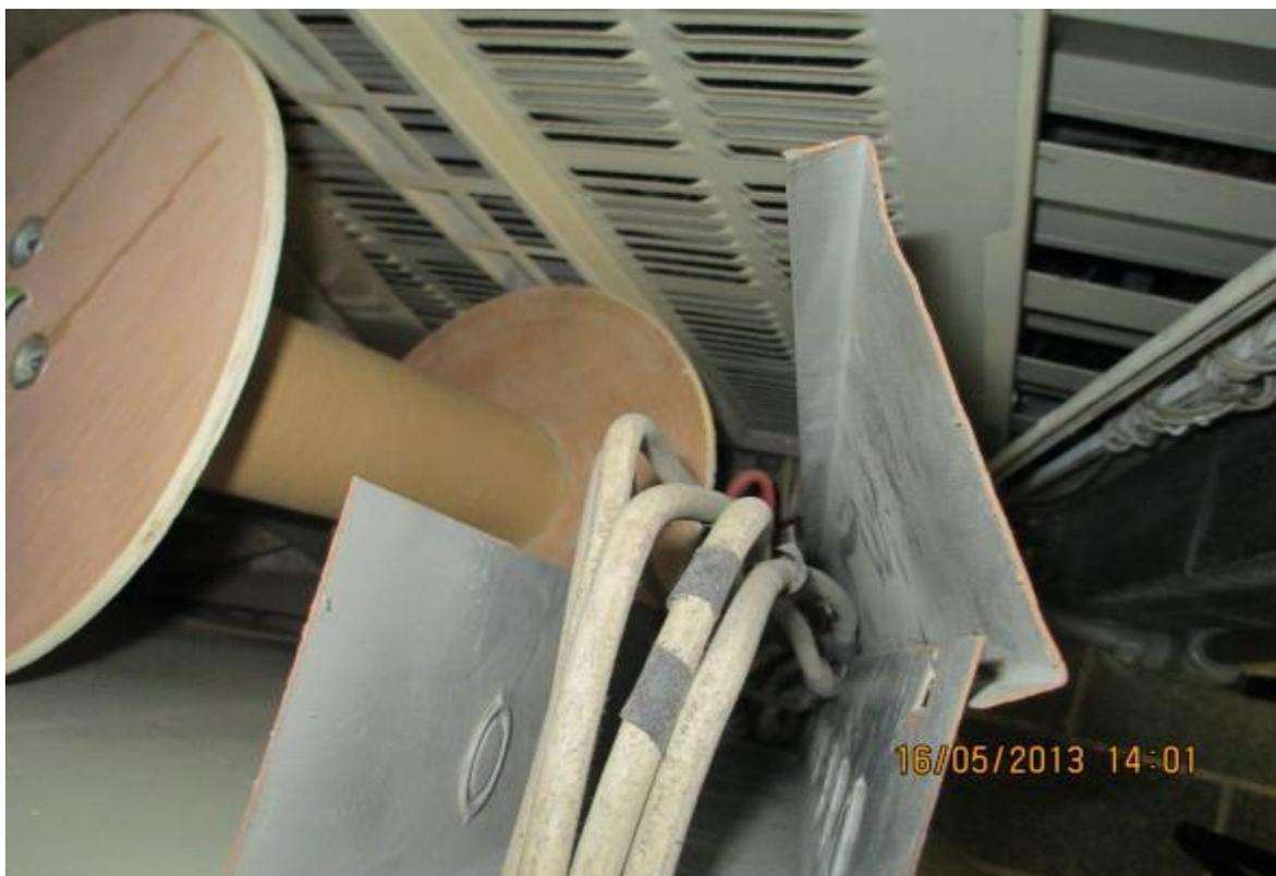
***Ilustración 72. Canalización que no protege alimentadores***
