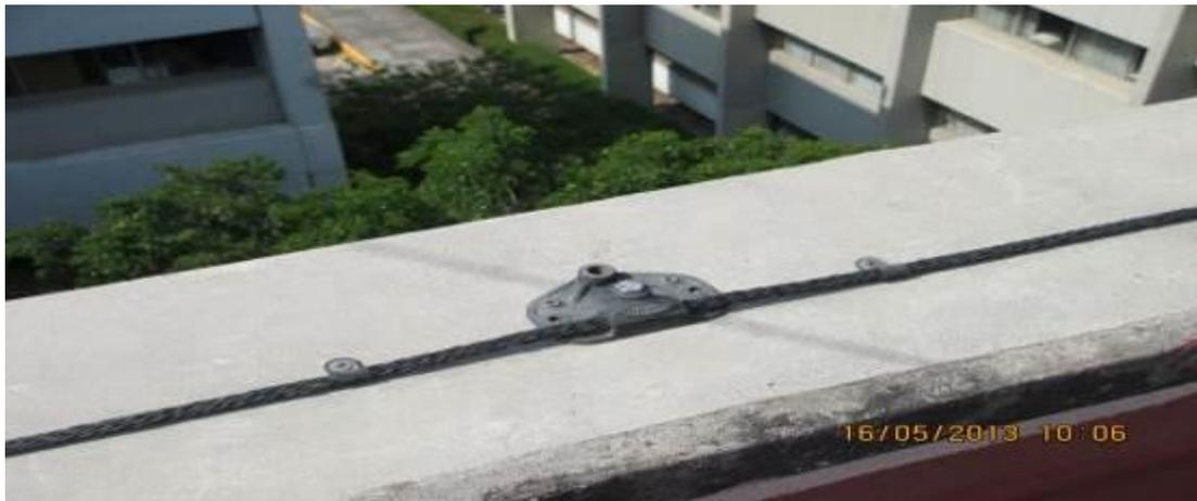
***Ilustración 74. Falta de punta de pararrayos***
