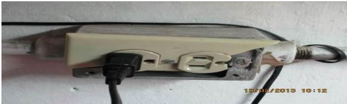
**Ilustración 15. Contactos en mal estado**
