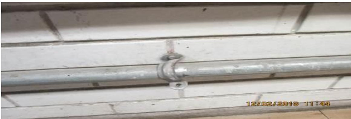
***Ilustración 19. Soporte de tubería dañado***
