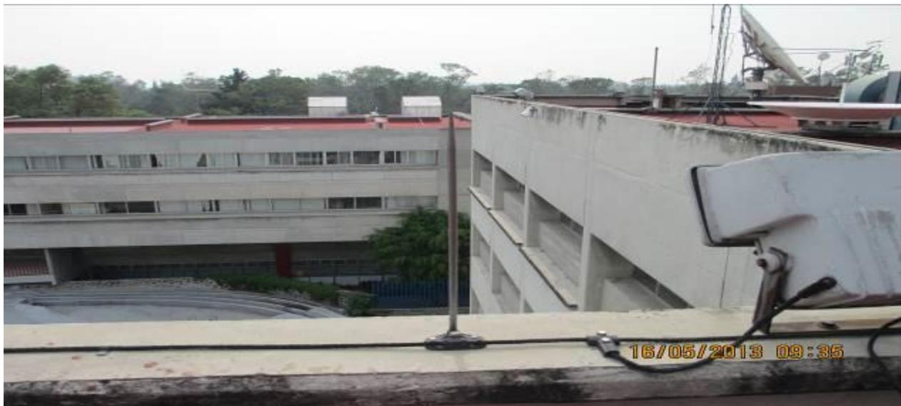
*Ilustración 10. Luminaria y punta de pararrayos, azotea*
