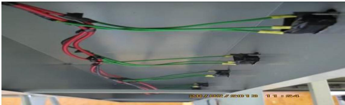
***Ilustración 51. Falta de canalización y protección para cables***
