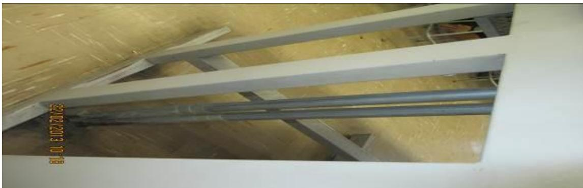
***Ilustración 21. Tubería oxidada***
