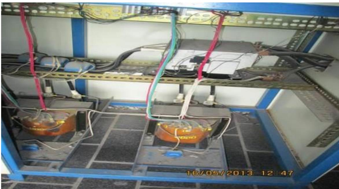
**Ilustración 70. Falta de tapa del regulador**
