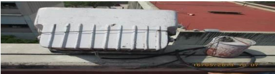
***Ilustración 82. Componentes de luminaria expuestos***
