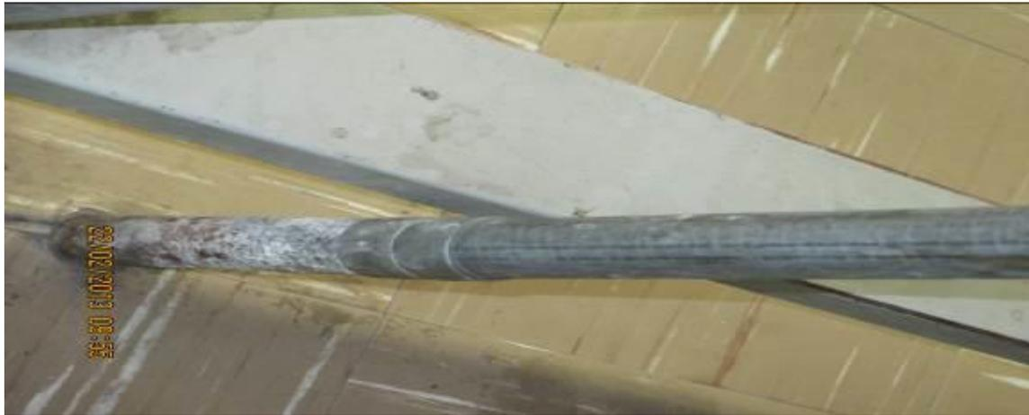
***Ilustración 25. Canalización oxidada***
