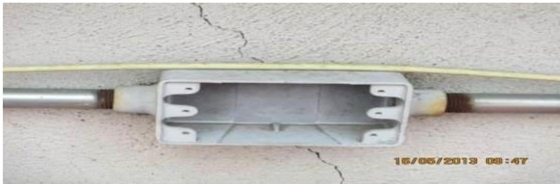
***Ilustración 77. Canalizaciones sin utilizar***
