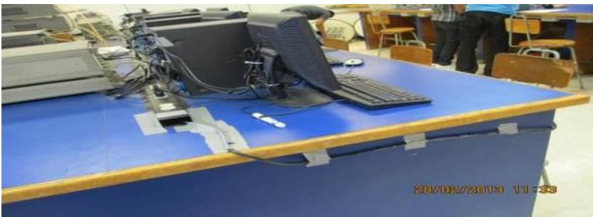
***Ilustración 49. Alimentación provisional conectada a un solo contacto***
