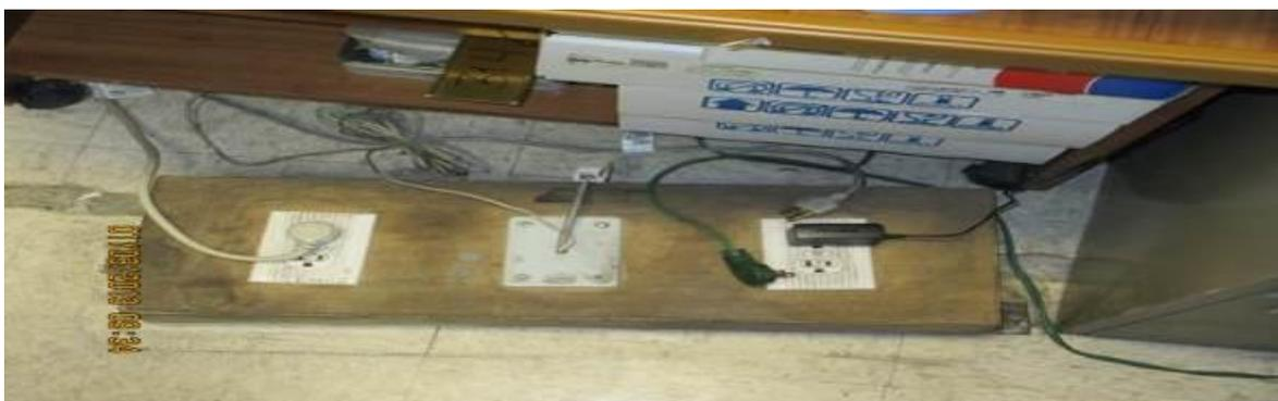
***Ilustración 58. Contactos provisionales empotrados sobre madera***
