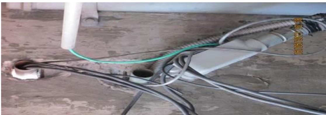
***Ilustración 79. Cables sin protección***
