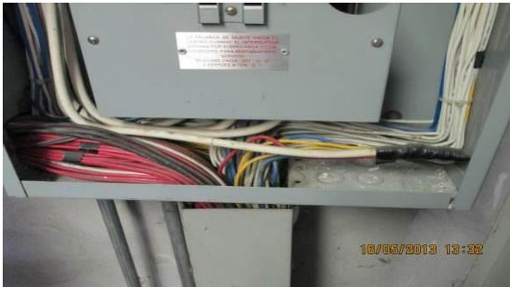
***Ilustración 67. Salida de cables mal cerrada***
