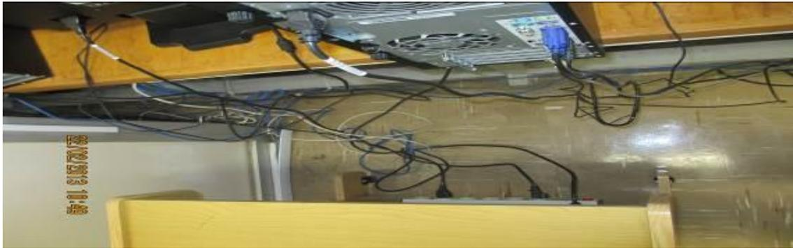
***Ilustración 42. Uso de multicontacto en sustitución de la instalación fija***
