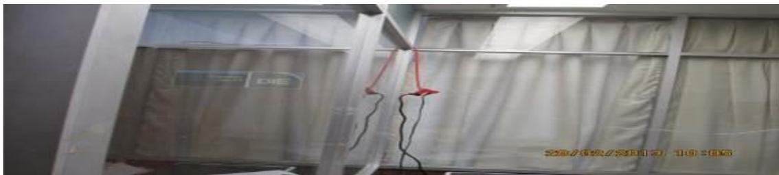
**Ilustración 46. Uso de extensiones en sustitución de la instalación fija**
