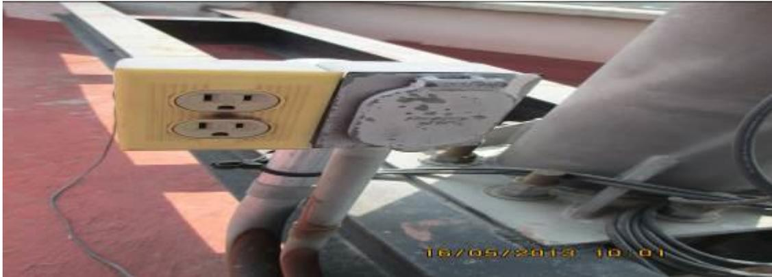
***Ilustración 80. Contacto para uso en interiores***
