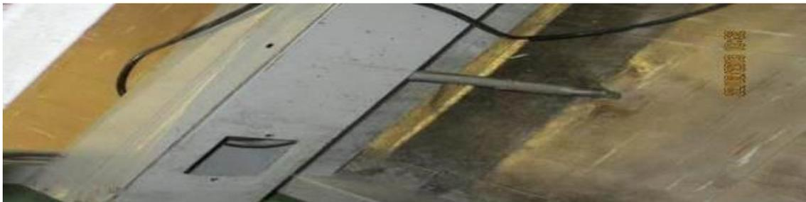
***Ilustración 44. Espacios sin tapa y tubería oxidada***
