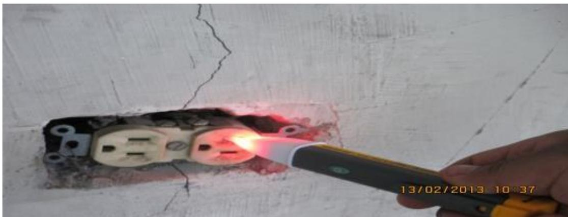
***Ilustración 28. Polarización incorrecta***
