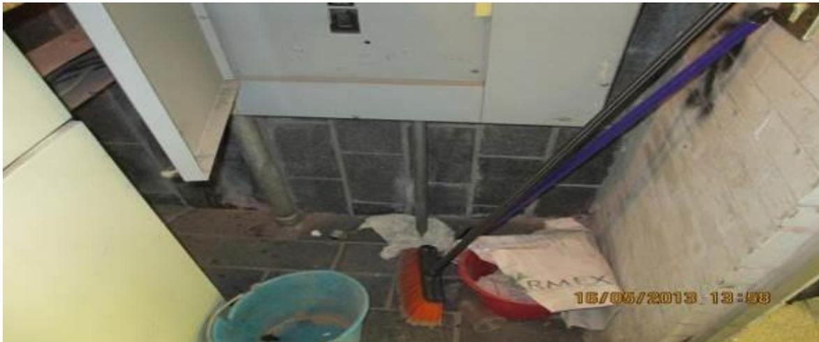
**Ilustración 69. Cuartos eléctricos usados como bodegas**
