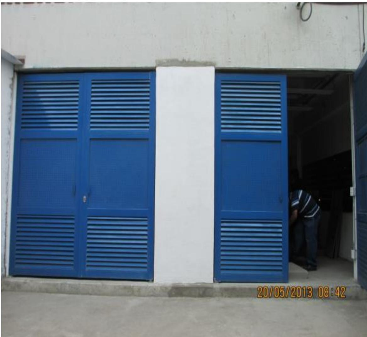
***Ilustración 89. Falta de letreros de advertencia (subestación)***
