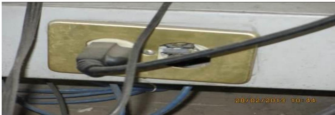
***Ilustración 37. Contacto dañado***
