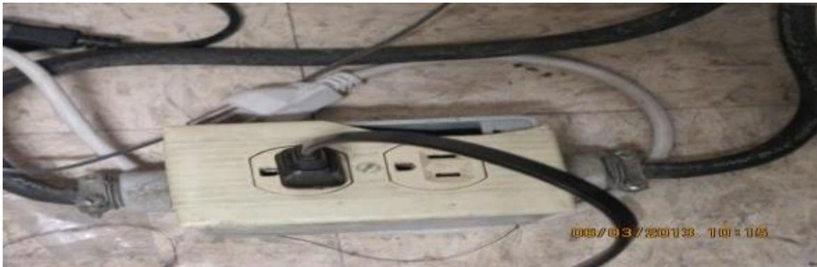
***Ilustración 56. Contactos provisionales con tapa rota***
