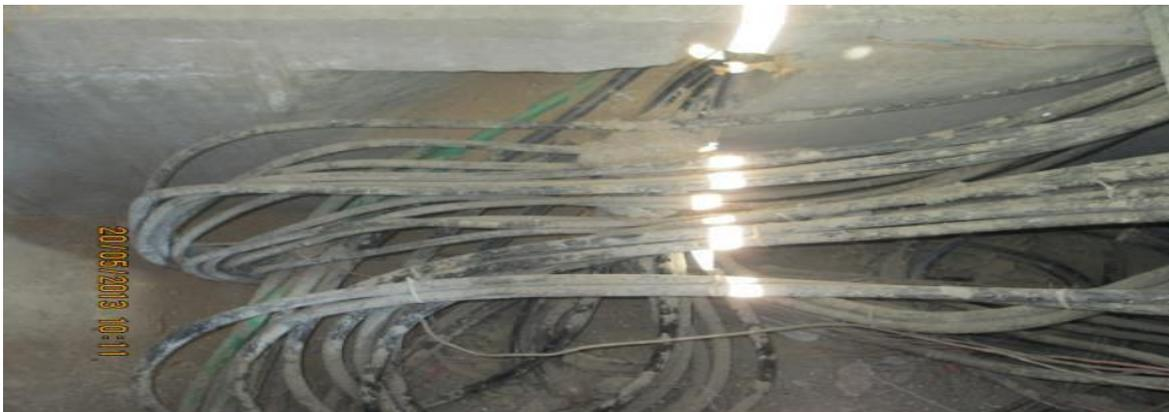
**Ilustración 86. Trincheras sin tapa y en mal estado**
