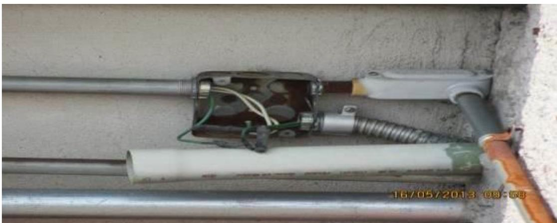
***Ilustración 78. Cajas oxidadas, sin tapas y empalmes expuestos***
