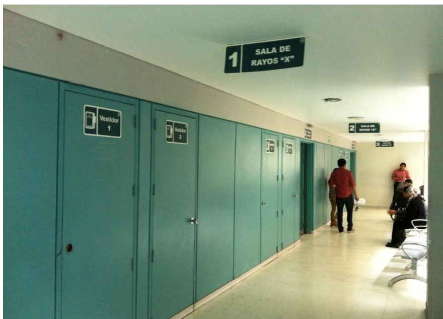
Figura 2.9 Sala de rayos X No.1
