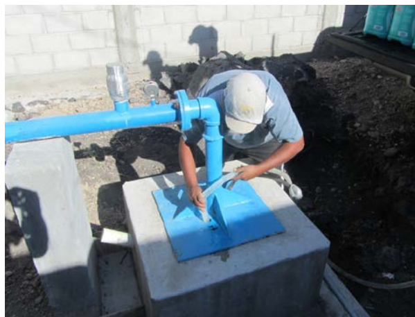
Evidencia grafica de la cloración del pozo
