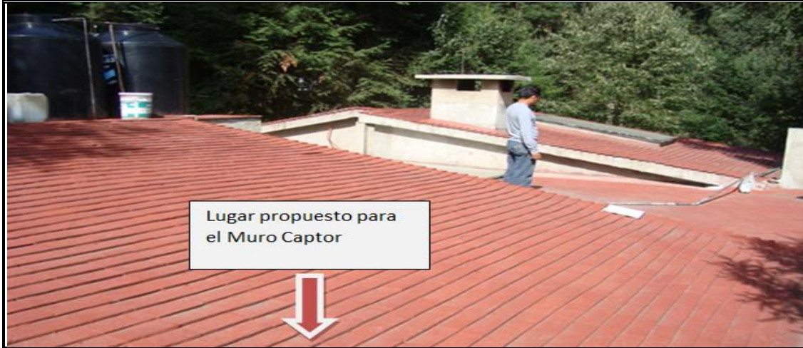
Figura 5.9 Lugar propuesto muro 1
