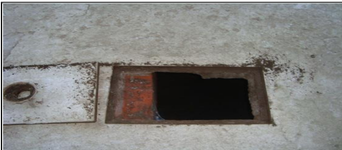
Figura 5.45 Fotografía de fosa séptica desde el exterior de la casa en estudio
