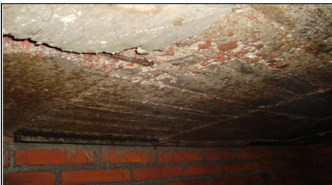
Figura 5.47 Techo de la fosa séptica de la casa en estudio (interior)
