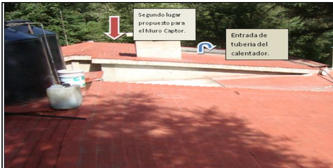
Figura 5.10 Punto propuesto muro 2
