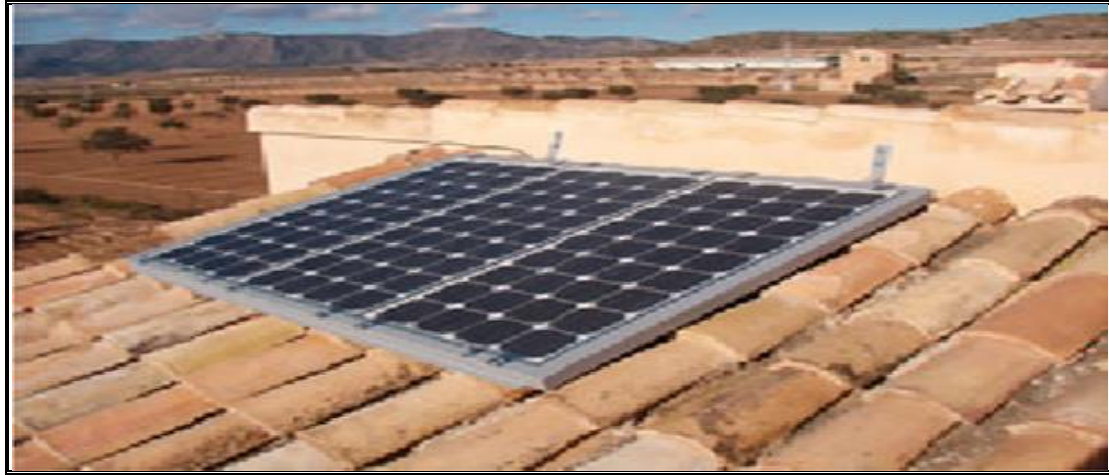
Figura 3.3 Celdas fotovoltaicas en techo de casa (ES, 2009)
