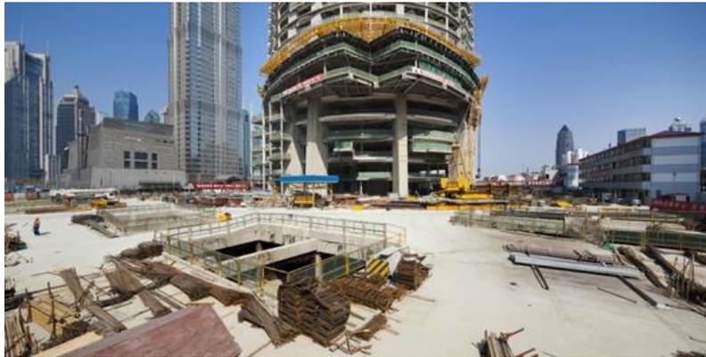
**Fig.2.10, A finales de abril de 2011, el refuerzo de acero de la torre se había subido a la planta 18, mientras que su núcleo de hormigón había llegado a la planta 15, y el piso encuadre se había completado hasta el cuarto piso.**
