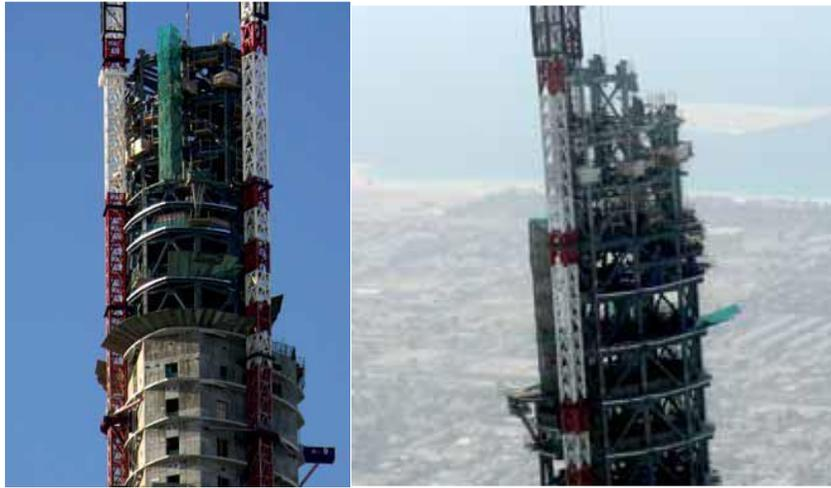
**Fig. 2.08, Cuerpo del Burj Khalifa, cuenta con 7 niveles mecánicos localizados a lo largo del edificio cada 30 pisos, en donde se sitúa la maquinaria que controla los sistemas del edificio como las estaciones eléctricas o las bombas de agua.**
