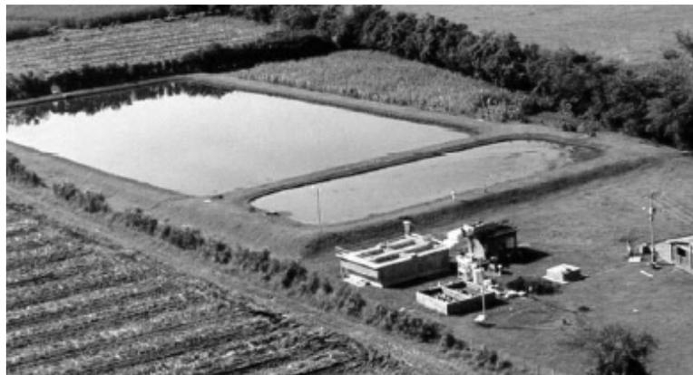
**Figura 3.2.** Sistema de laguna de estabilización, consistente en una laguna anaerobia y una facultativa (Peña & Mara, 2004)
