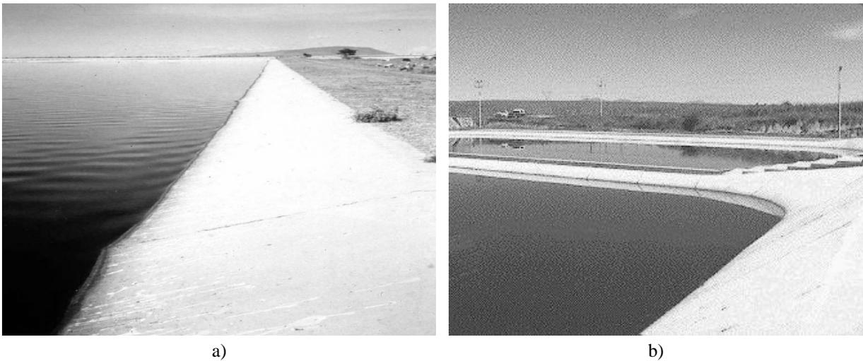
**Figura 3.12.** Protección contra oleaje a base de losa de concreto (cortesía Ing. F. Pozo, IMTA)
