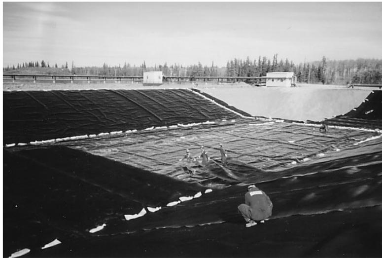
**Figura 3.39.** Ejemplo de colocación de una geomembrana en una laguna.
