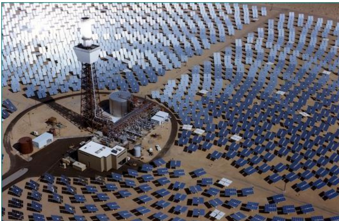
Figura 3.8 Campo de helióstatos con torre central. Daggett, CA. (NREL)
