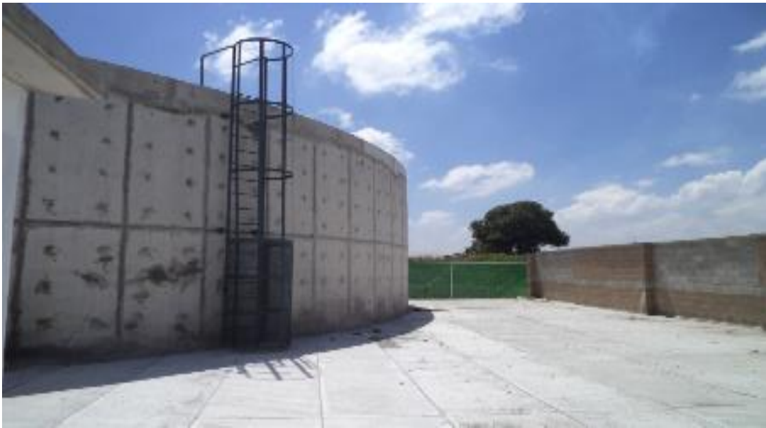
FOTO 2. Vista general de patio
