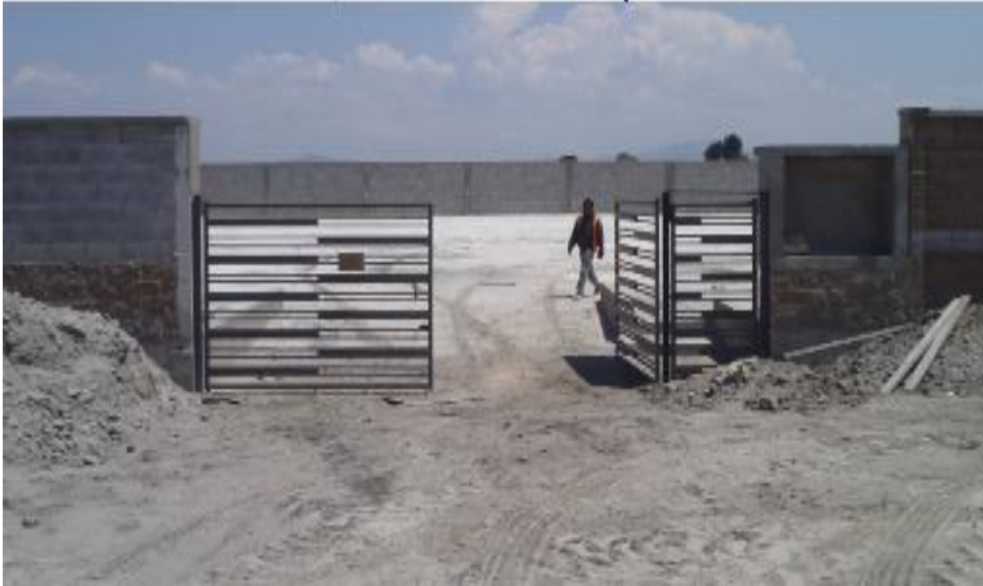
FOTO 5. Acceso al predio del pozo y cisterna
