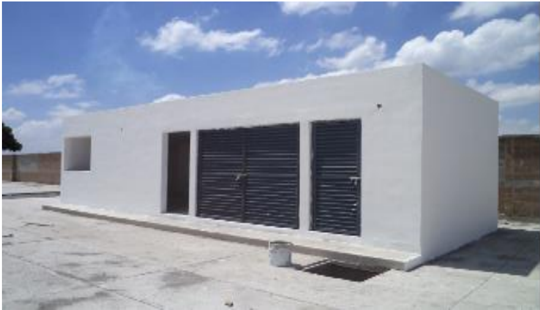
FOTO 3. Caseta de pocero y Cuarto de control de máquinas
