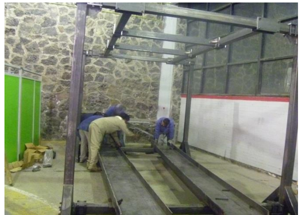
Figura [5.4] Proceso de ensablado del “frame” (Ensamble de los rieles).
