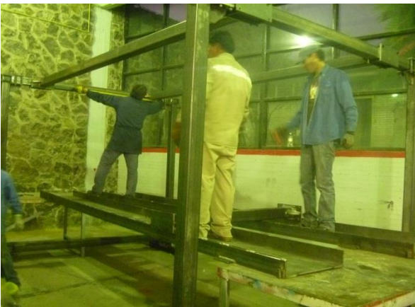
Figura [5.3] Proceso de ensablado del “frame” (Ensamble de los travesaños y largueros).
