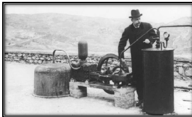
Figura 4. Primera Instalación de generación eléctrica en Larderello [2].
