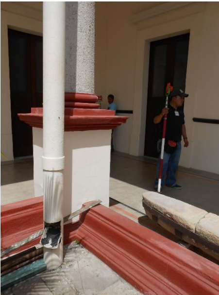
Ilustración 17. Descarga de la tubería de bajada.
