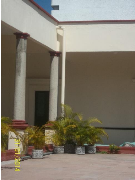
Ilustración 11 Tubería de bajada.
