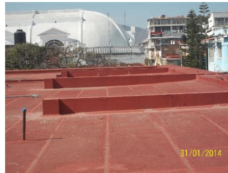
Ilustración 10. Traveses invertidas.
