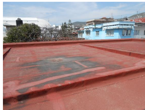
Ilustración 14. Detalles del impermeabilizante.
